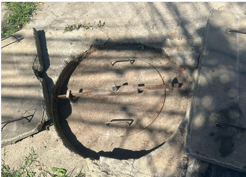
Foto 3 – Tampa de aço do “panelão”
