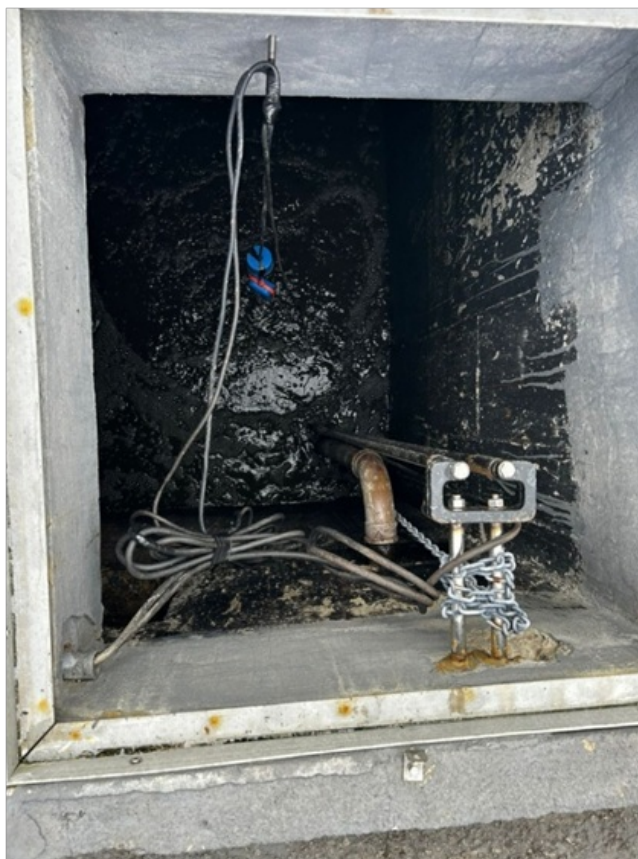
Foto 05 – Medidor ultrassônico efluente chegada
