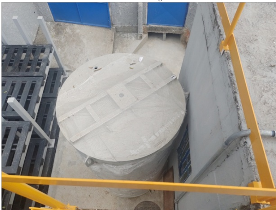
Foto 16 – Novo tanque de lodo
