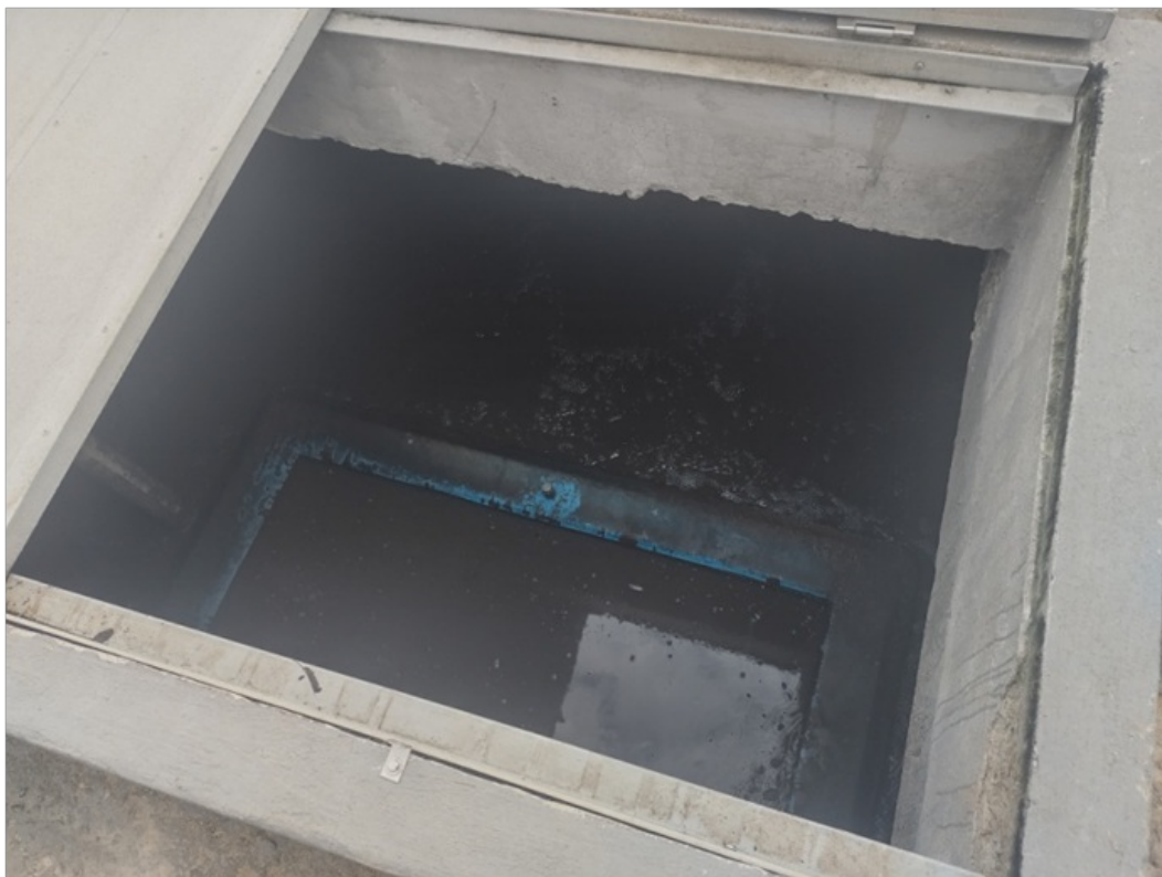
Foto 10 – Poço de visita reator
