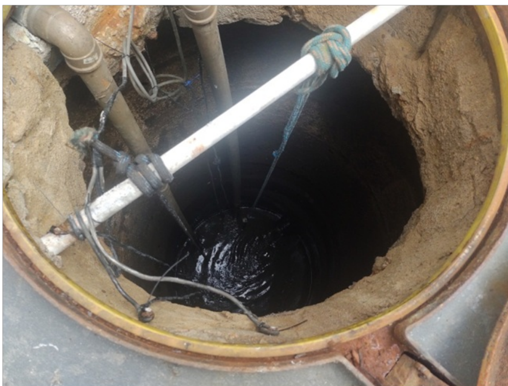
Foto 04 – Poço de sucção
