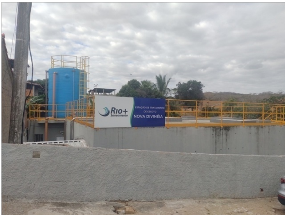
Foto 01 – Vista da fachada da ETE.
