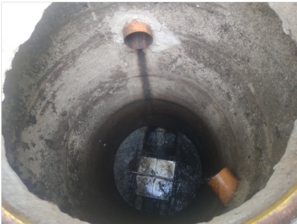
Foto 02 – Poço de chegada com gradeamento
