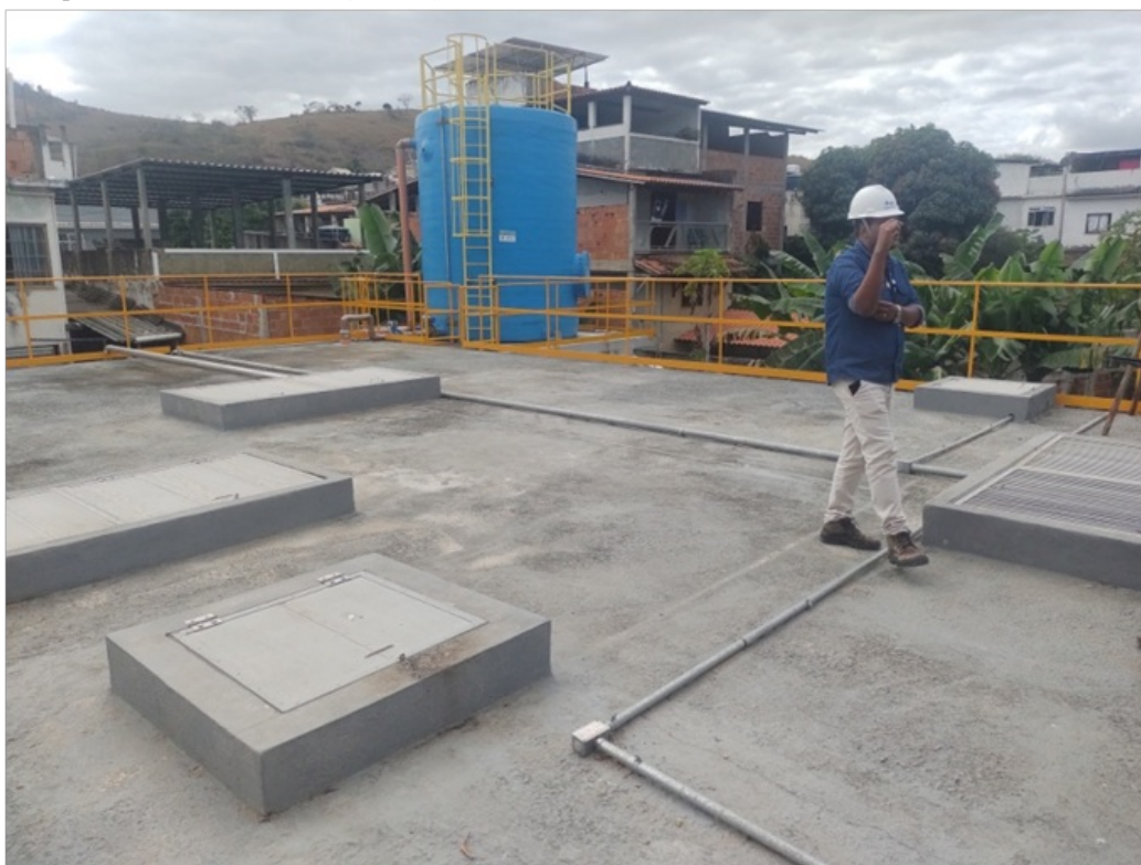
Foto 08 – Laje do reator SBR, ao fundo caixa de equalização
