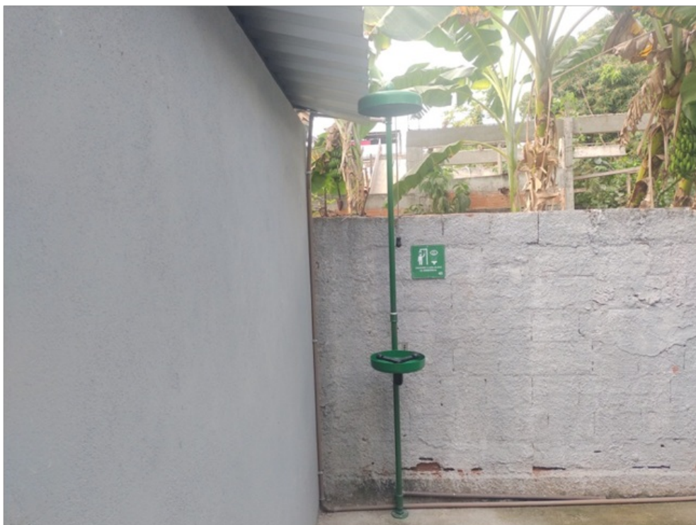
Foto 27 – Chuveiro de emergência
