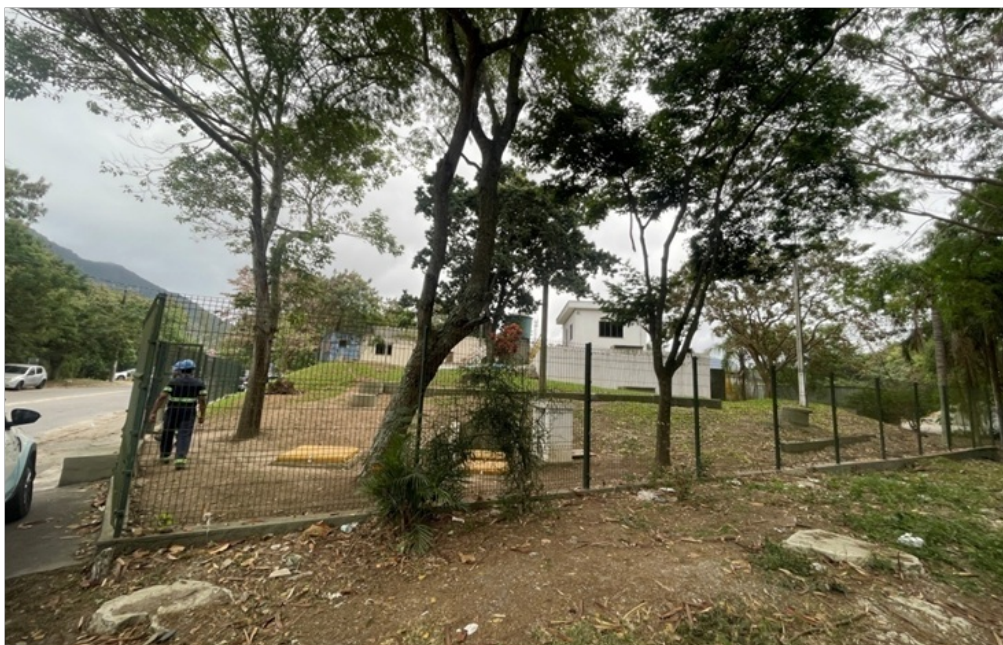
Foto 2 - Vista lateral da EEE Barra Bonita
