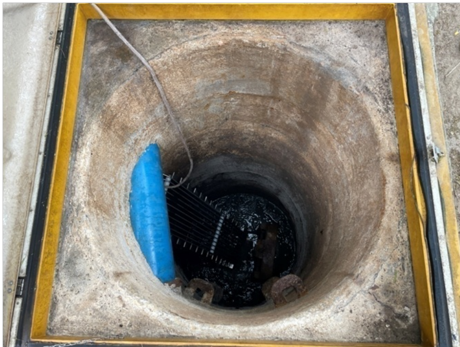
Foto 5 – Poço do gradeamento
