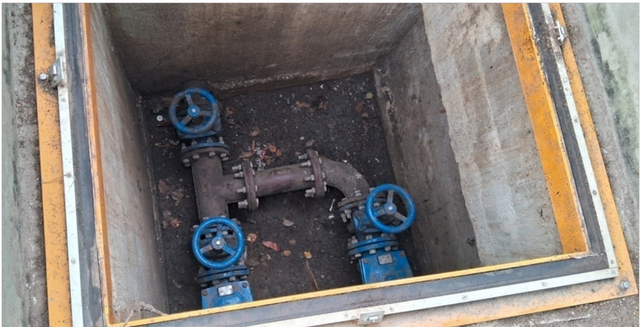
Foto 7 – Poço do barrilete
