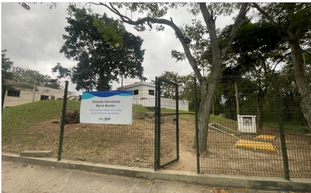
Foto 1 – Vista frontal da EEE Barra Bonita
