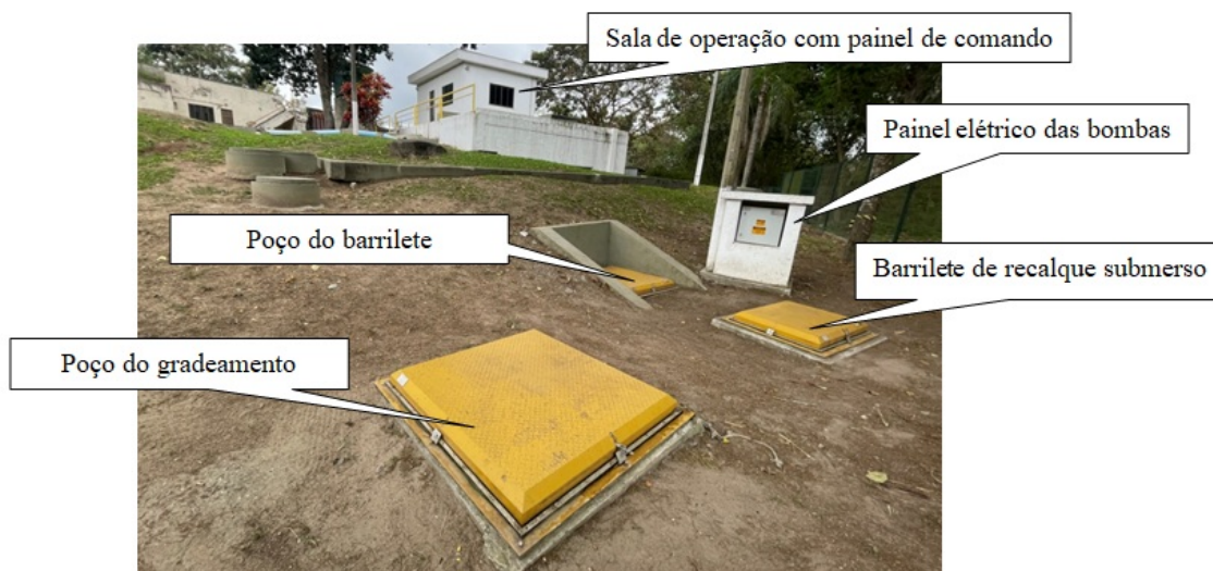
Foto 4 – Vista geral da estação
