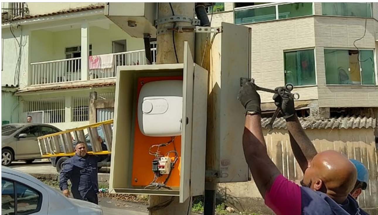
Foto 7 – Interior do painel de telemetria em bom estado de conservação
