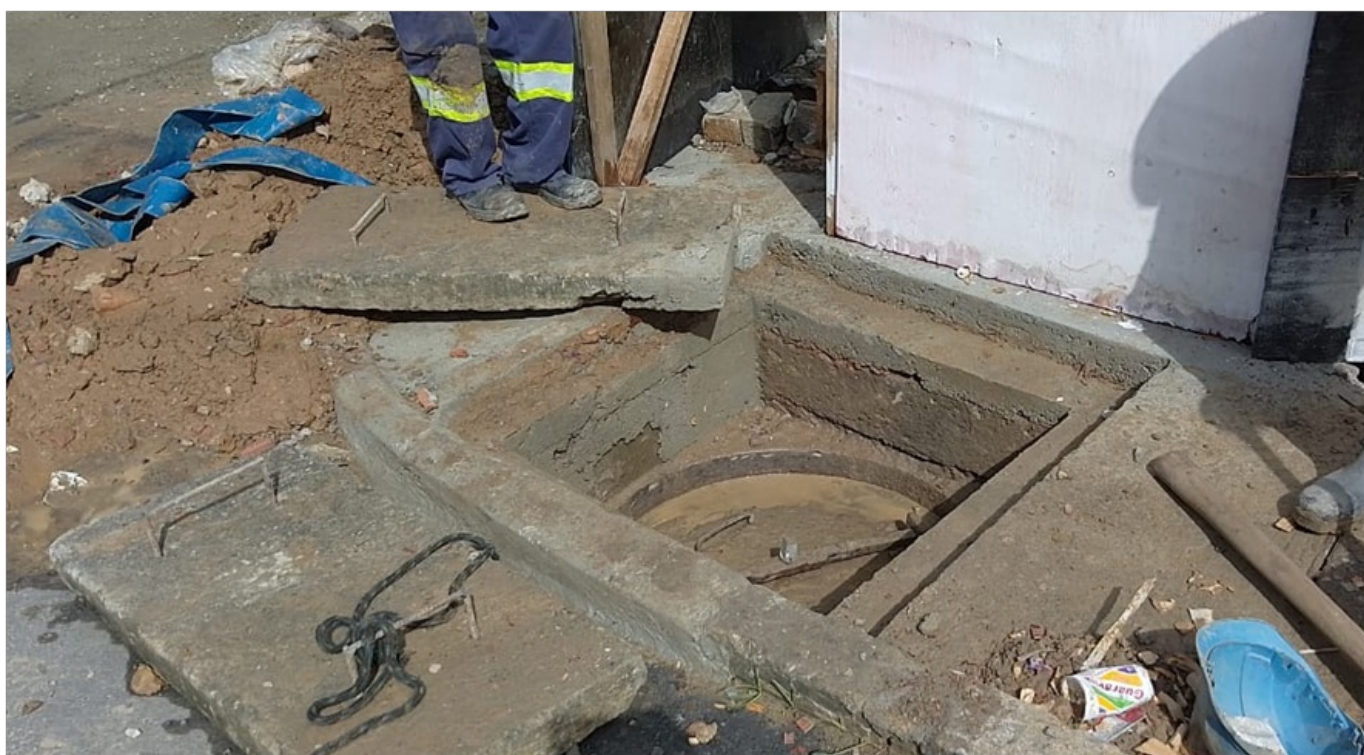
Foto 01 - Vista do abrigo do conjunto motobomba
