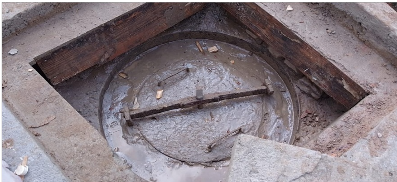
Foto 02 - Vista do tampo do panelão de aço do abrigo do conjunto motobomba.
