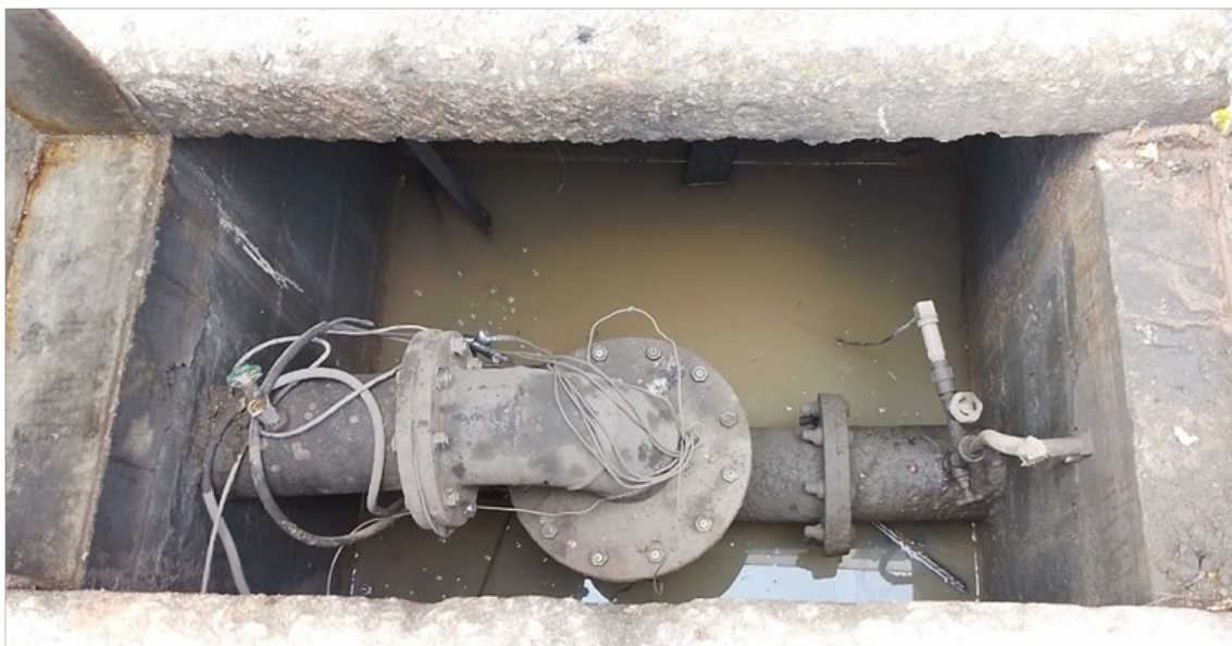
Foto 3 - Abertura do abrigo subterrâneo com visualização da jaqueta da bomba e presença de água no poço
