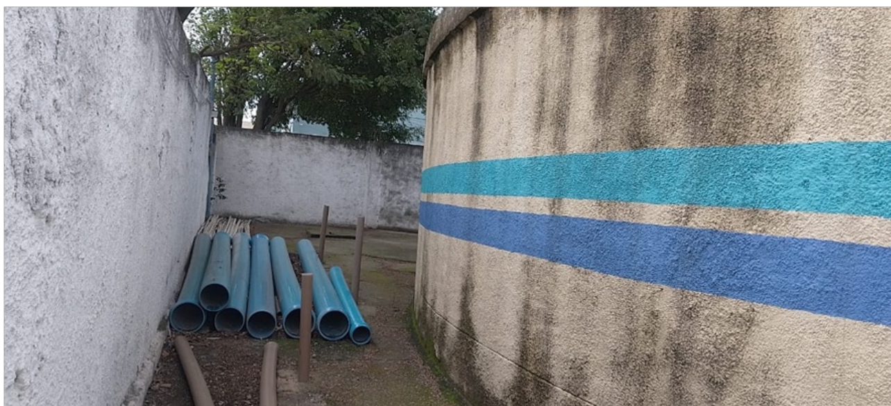
Figura 4 - Entorno do reservatório (lado esquerdo)
