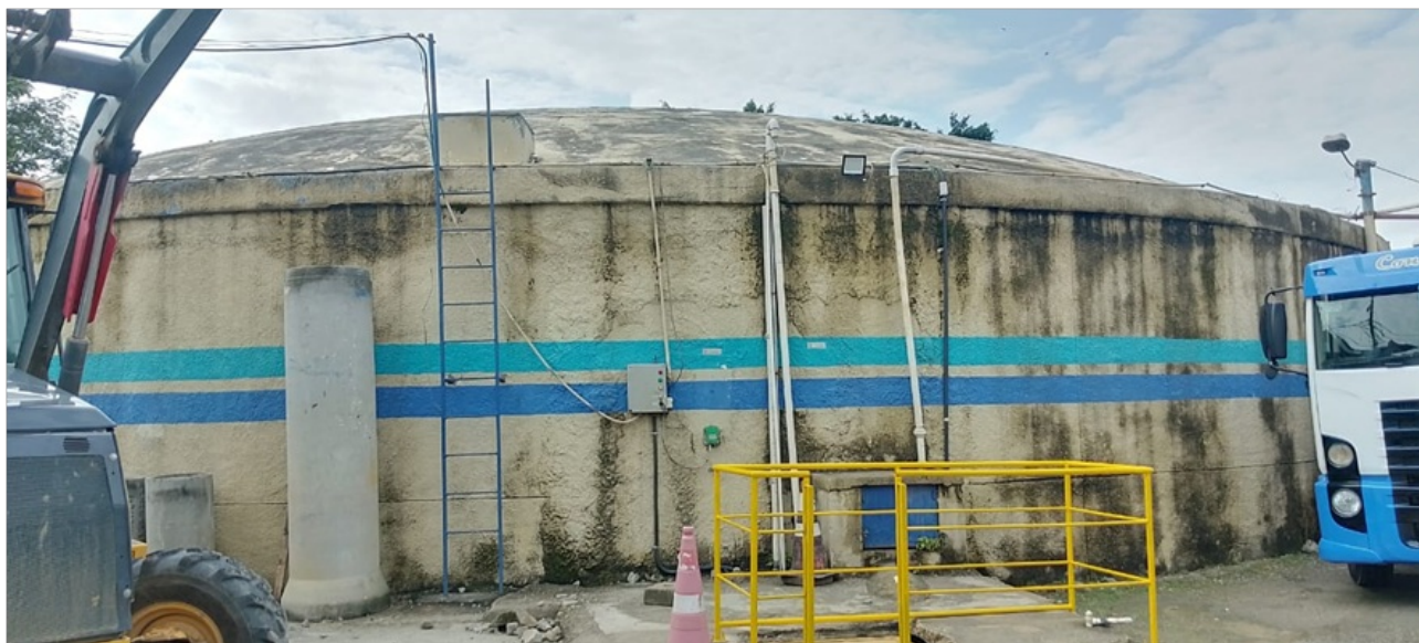
Figura 2 - Reservatório do tipo semienterrado com capacidade de 2.500 m 3
