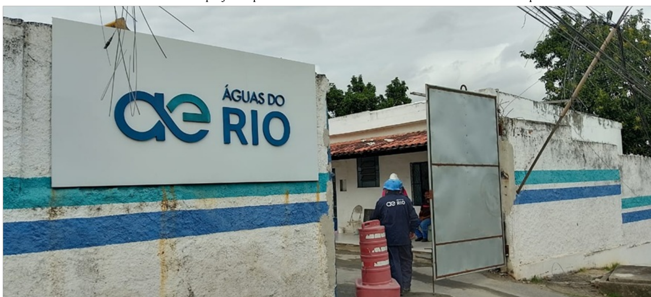
Figura 1 - Entrada da unidade do reservatório, com controle de acesso e sem identificação da unidade.
