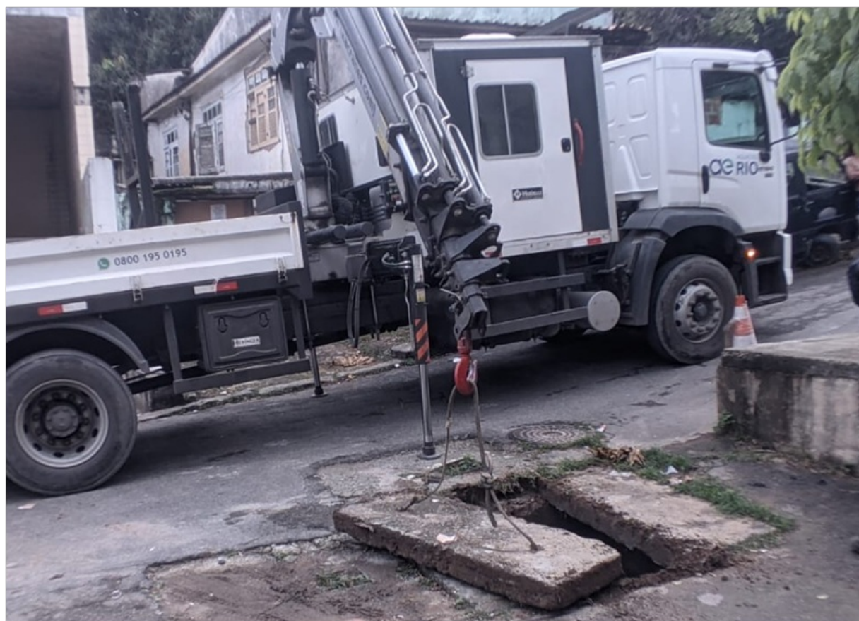
Foto 2 - Caminhão munck realizando a retirada da tampa de concreto
