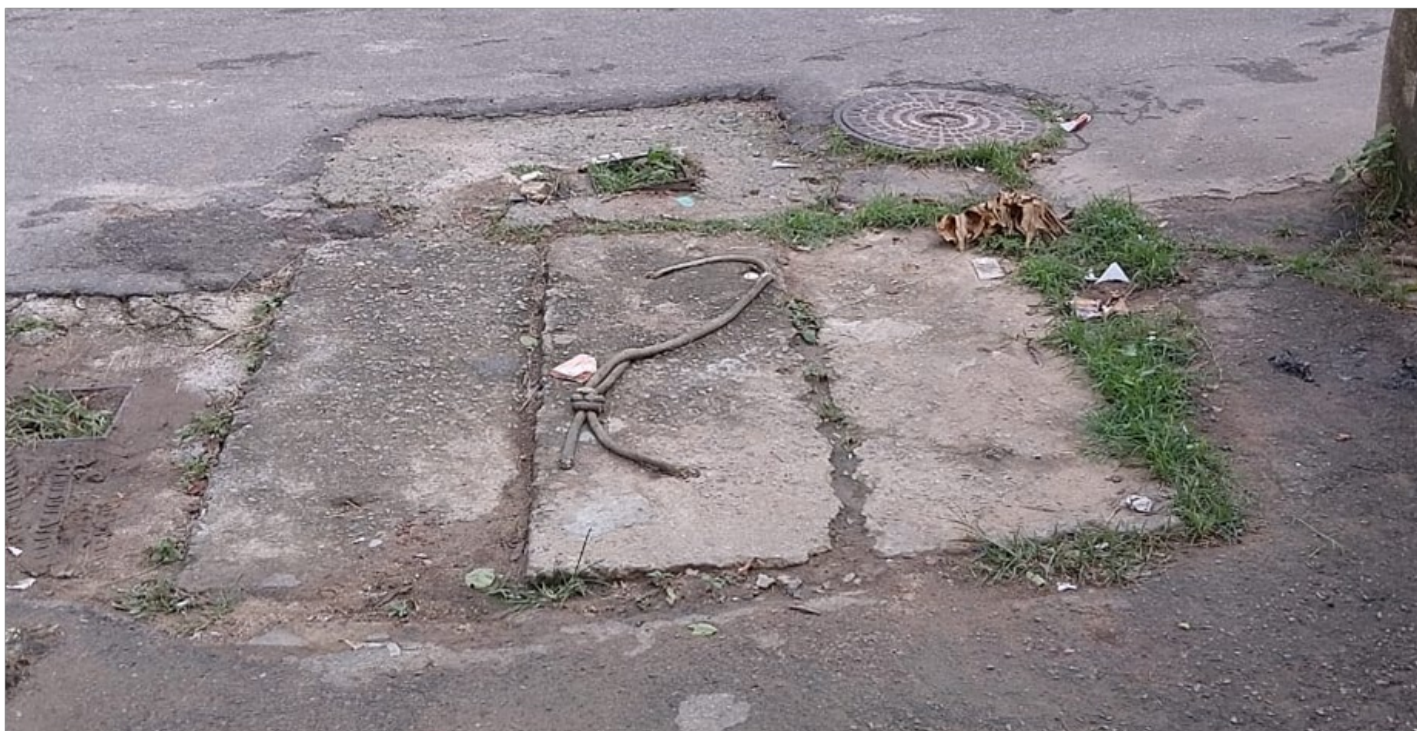
Foto 1 - Abrigo do conjunto motobomba com 3 (três) tampas de concreto
