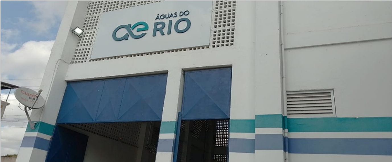
Foto 01 – Vista geral da estação elevatória de água tratada Nilópolis.
