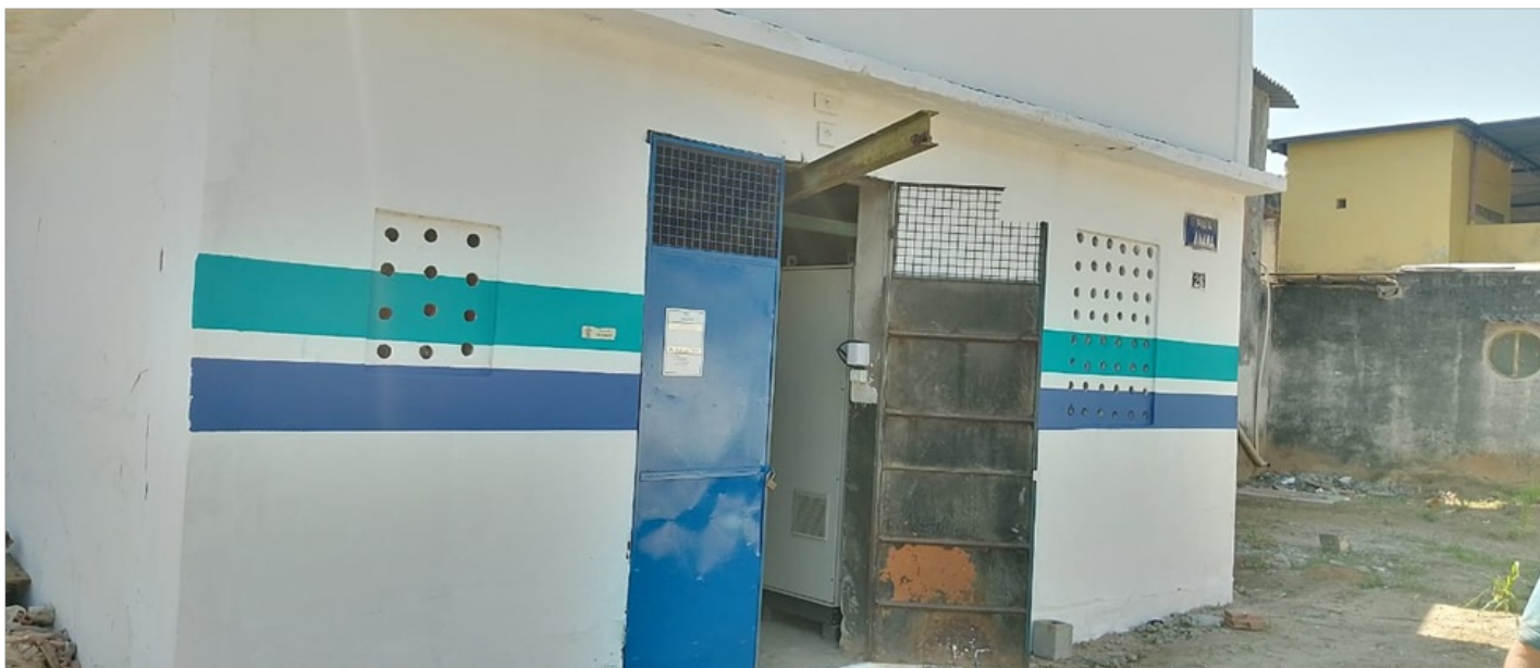
Foto 02 – Acesso ao abrigo dos conjuntos motobomba da Estação Elevatória.
