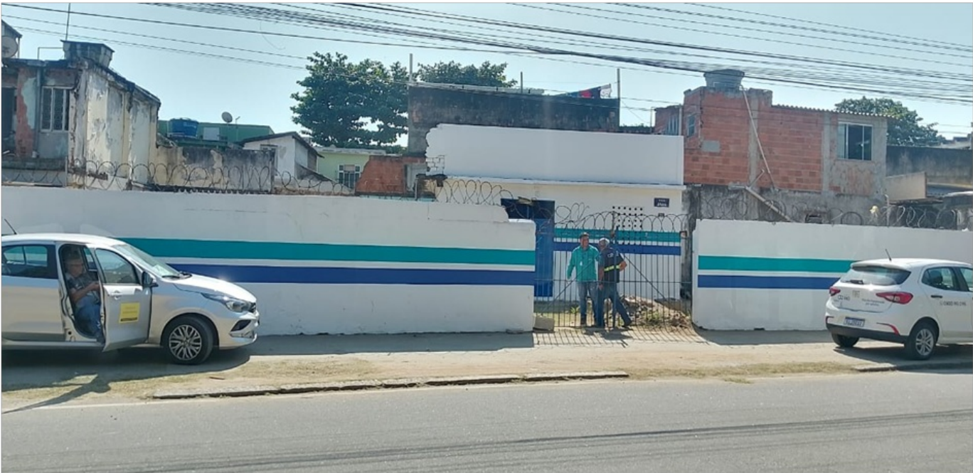
Foto 01 – Estação Elevatória de Água Tratada - EEAT 1055 – Parada de Lucas.
