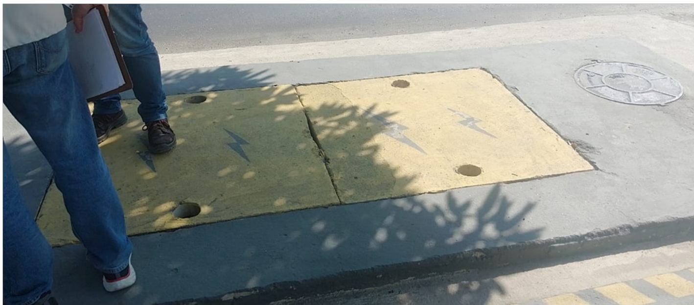
Foto 03 - Tampão de concreto do poço da bomba.
