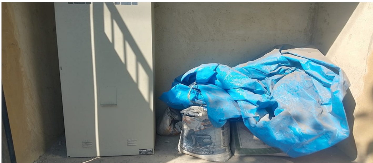
Foto 02 – Vista do interior do abrigo. Materiais armazenados em local inadequado.
