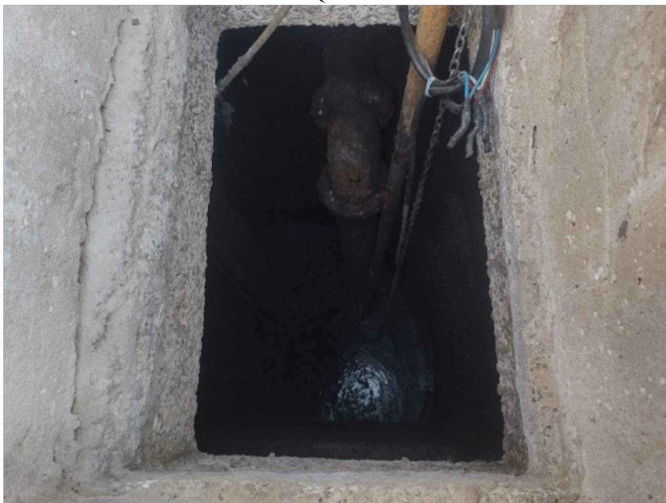
Foto 4 - Abrigo das bombas
