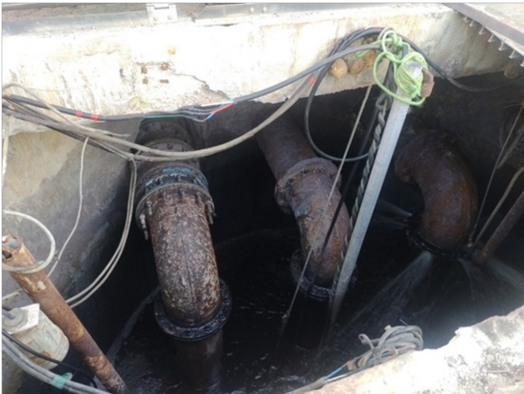
Foto 2 – Abrigo das bombas
