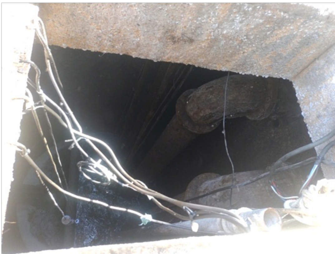
Foto 3 – Abrigo das bombas
