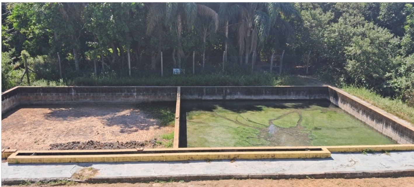
Foto 26 – Caixas de secagem do lodo
