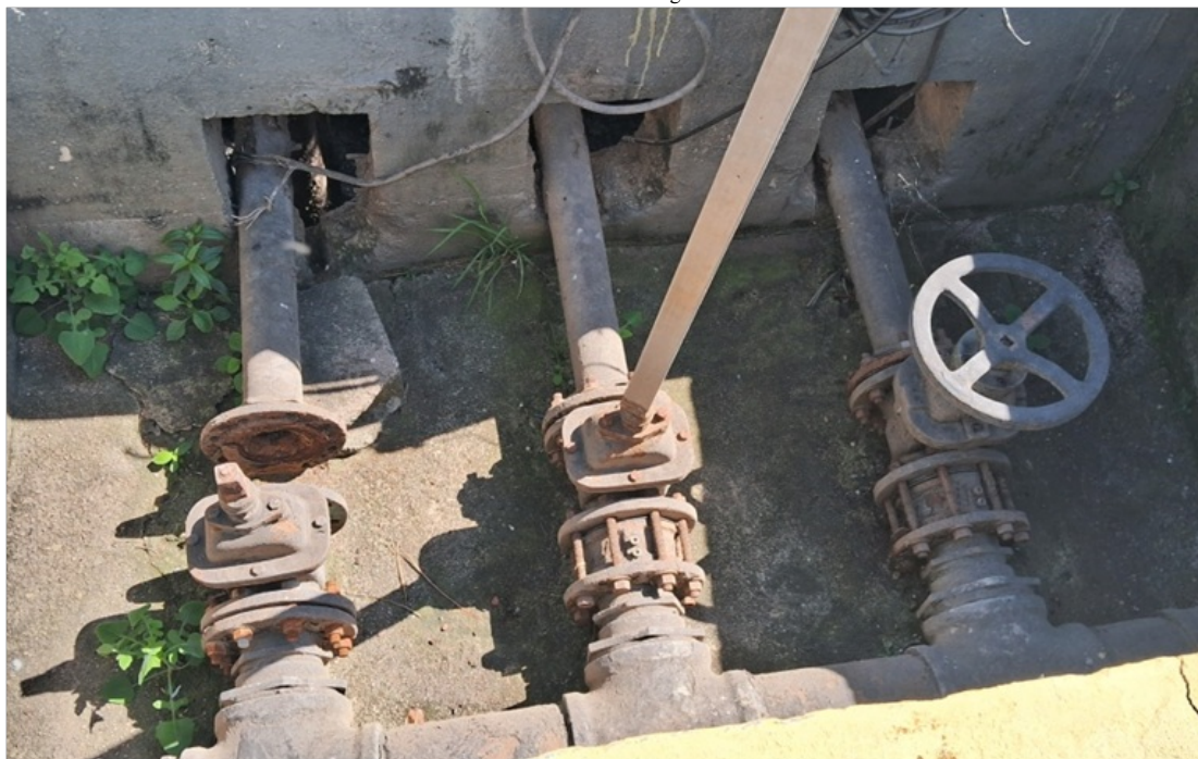
Foto 5 – Barrilete de recalque da EE bruto
