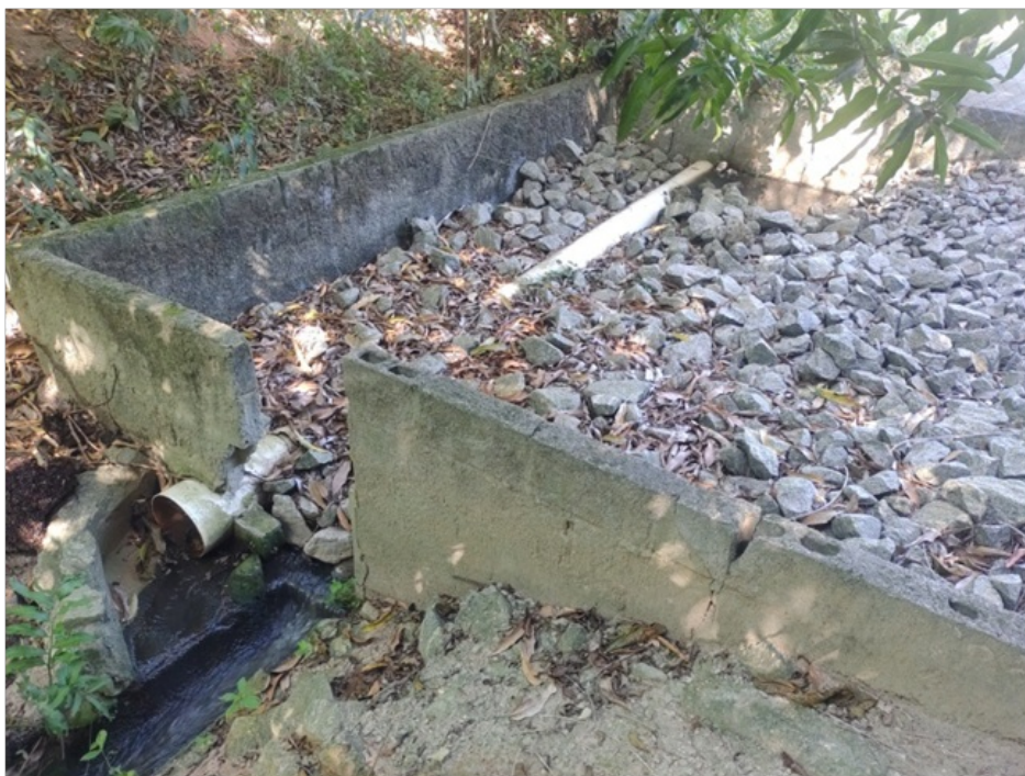
Foto 31 – Saída do efluente tratado ao corpo hídrico
