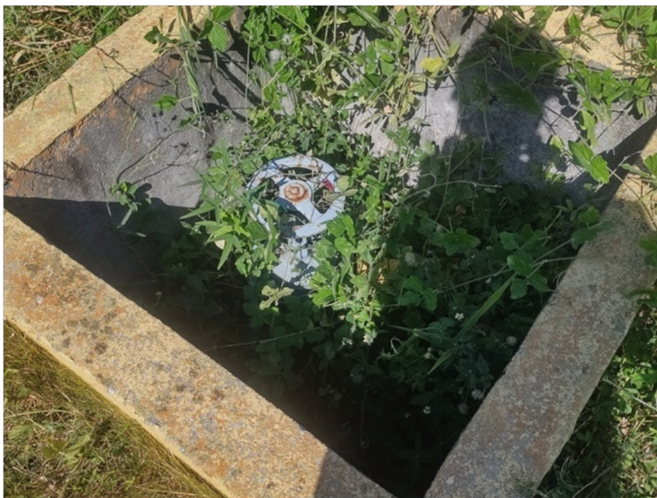
Foto 11 – Válvula do queimador
