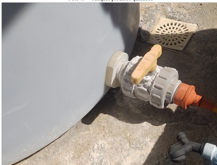
Foto 20 – Registro do tanque
