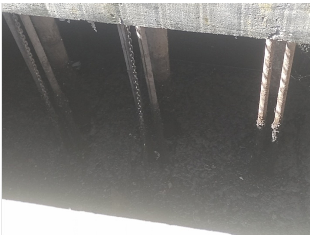
Foto 4 – Elevatória de esgoto bruto
