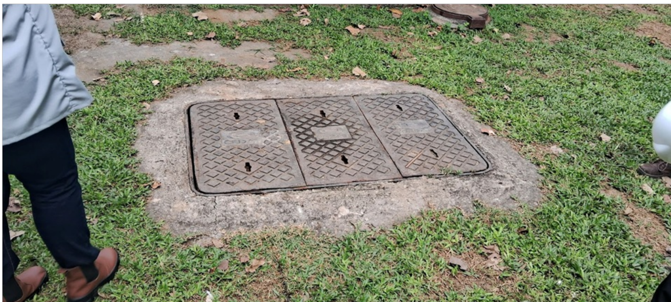
Foto 2 - Vista do tampão triplo metálico do gradeamento, que está em área externa à estação. Sem não conformidades.
