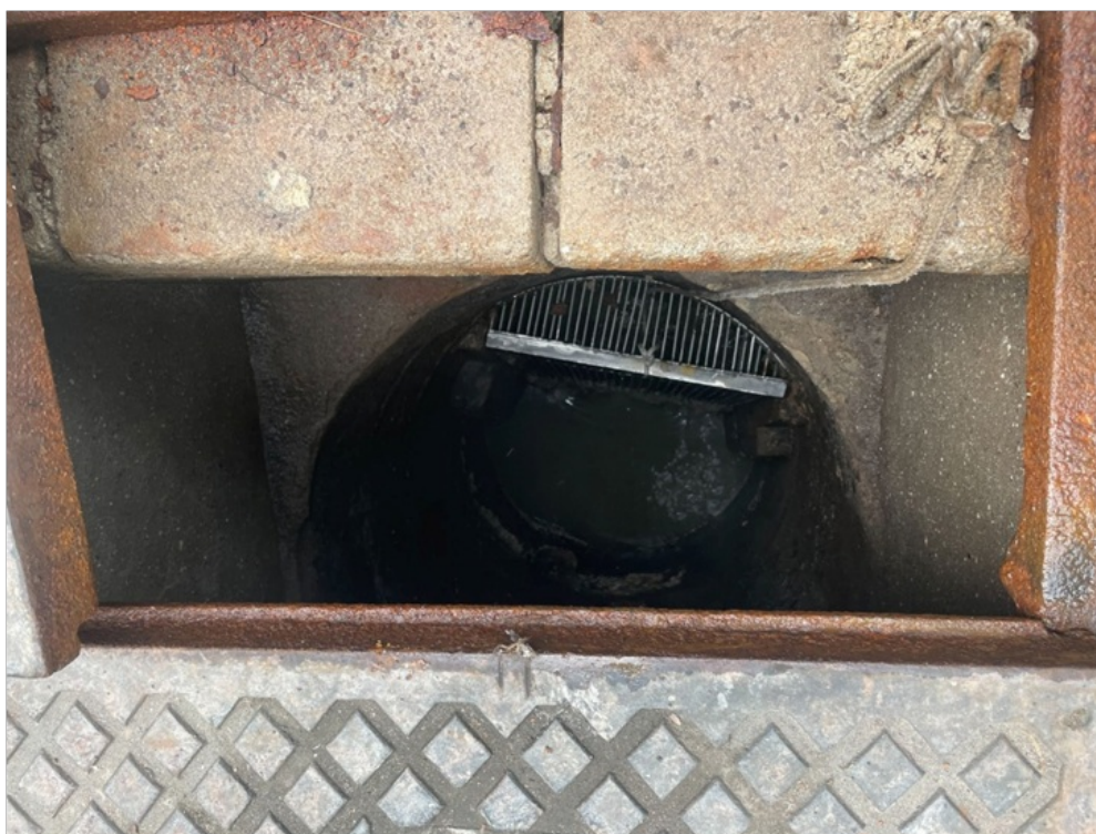
Foto 3 - Vista do interior do poço de gradeamento. Sem não conformidades.
