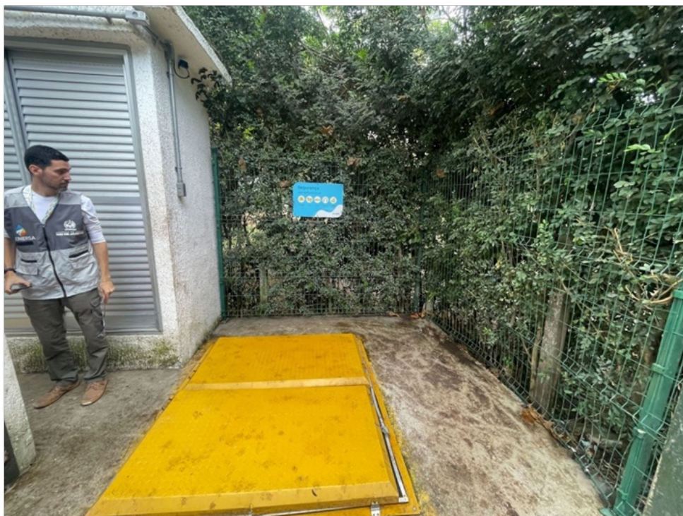
Foto 4 - Vista das tampas bipartidas do poço de sucção, que são articuladas e de plástico reforçado em fibra de vidro (PRFV). Sem não conformidades
