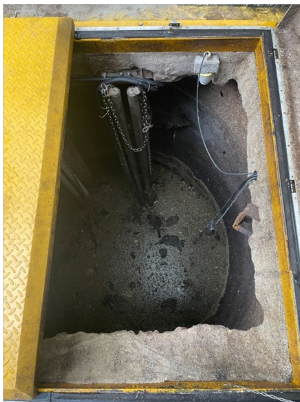
Foto 5 - Vista interna do poço de sucção, que estava com as bombas submersas no efluente. Sem não conformidades.
