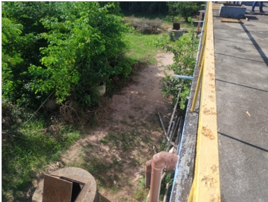
Foto 10 – Tubulações e pv de saída
