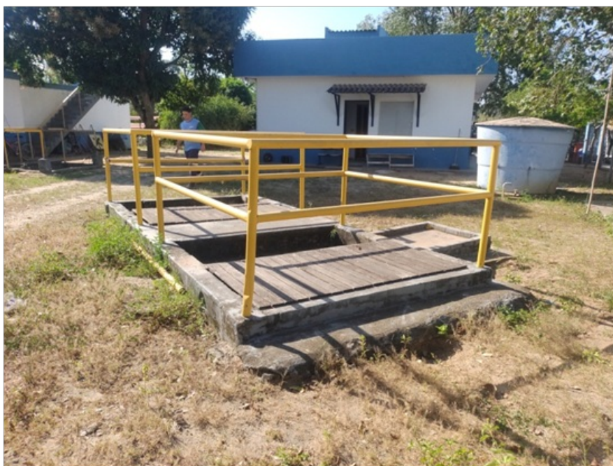
Foto 1 - Poço de chegada
