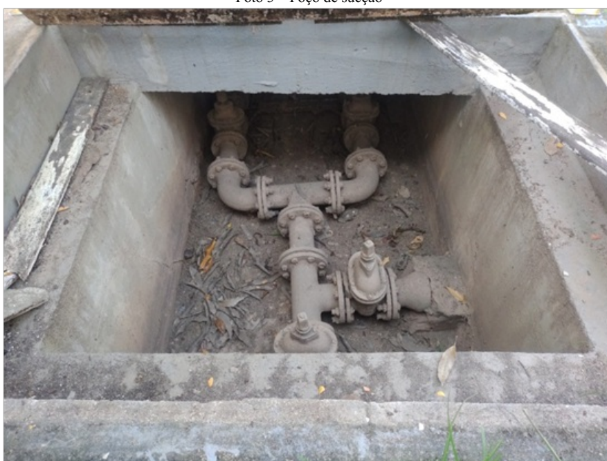
Foto 3 – Poço de sucção
