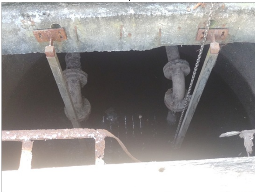
Foto 3 – Poço de sucção
