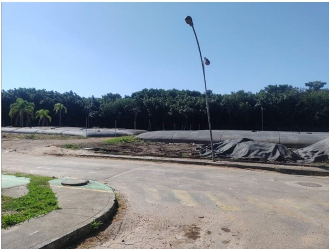
Foto 23 – Geobags de lodo
