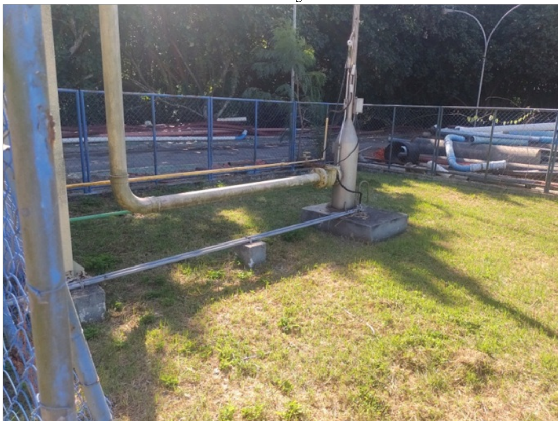
Foto 24 – Queimador de gases
