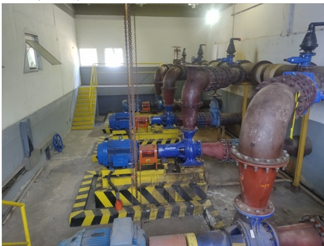
Foto 26 – Elevatória de esgoto tratado
