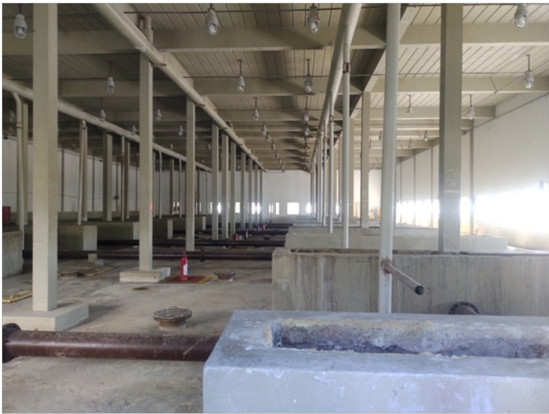
Foto 21 – Laje superior dos 3 reatores inoperantes
