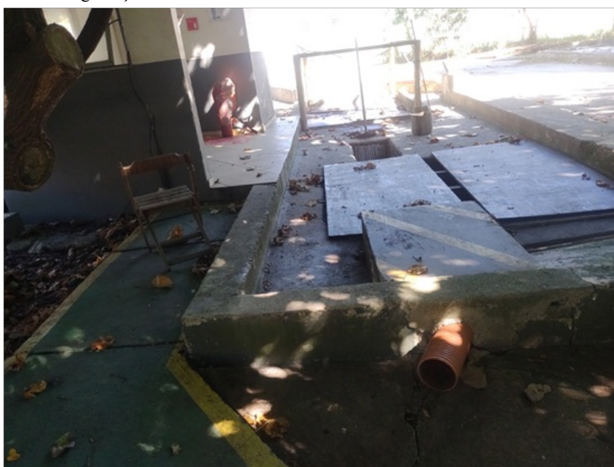
Foto 1 – Recepção dos efluentes de caminhão vacal
