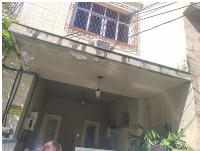
Foto 4 – Fachada R. Aquidabã, 805 casa 57
