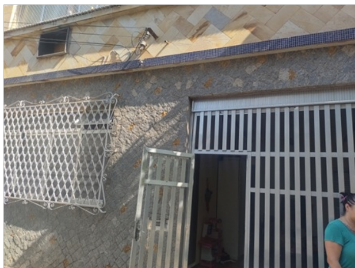
Foto 2 – Fachada R. Aquidabã, 805 casa 36
