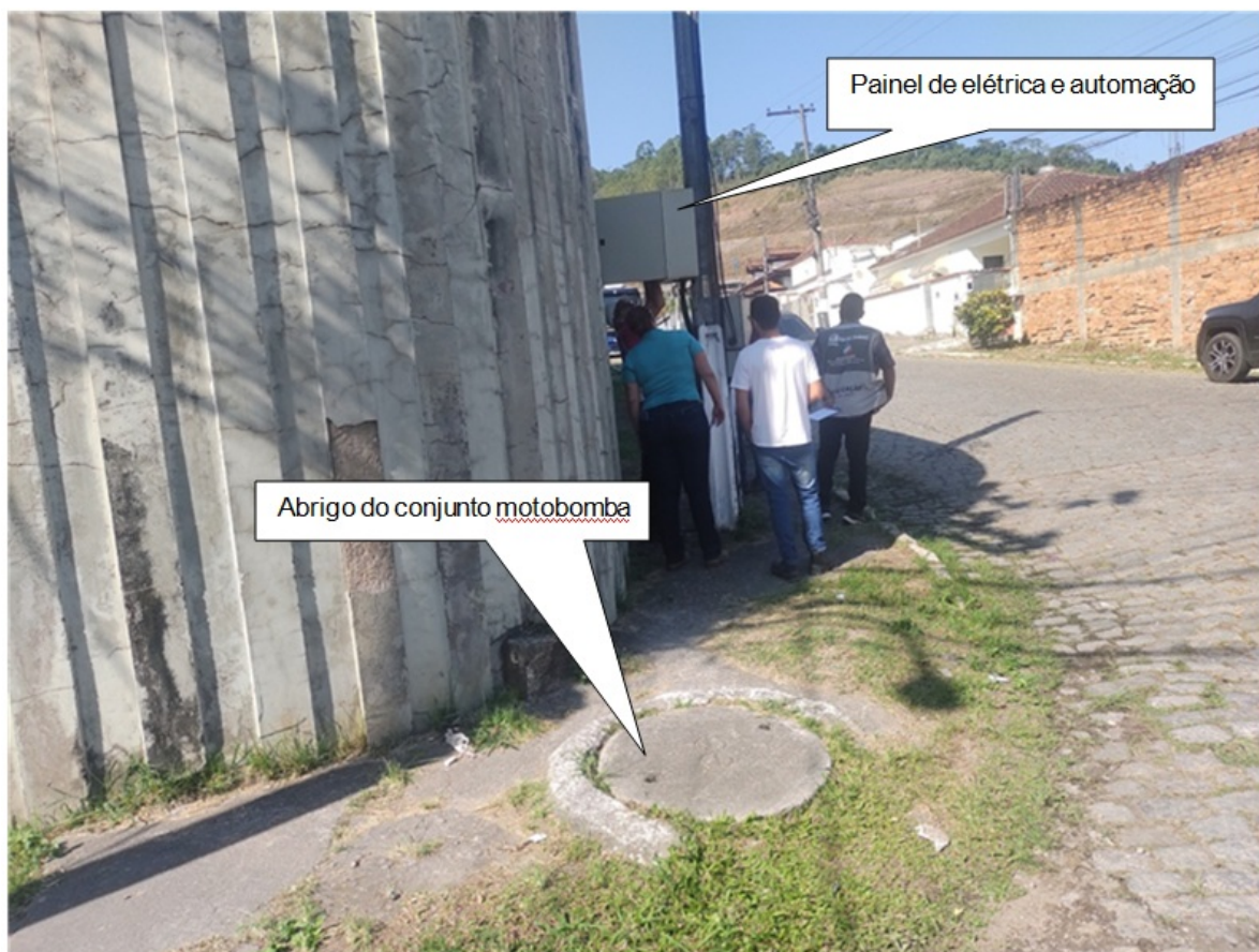
Foto 1 - Localização da EEAT Ojuara
