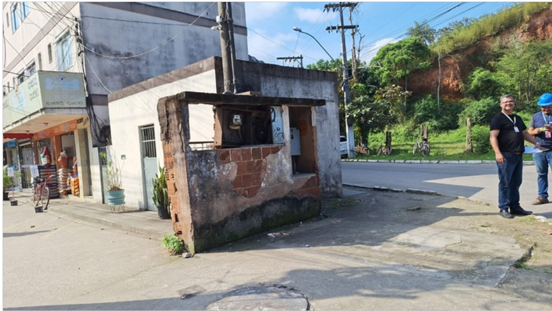
Foto 2 – Abrigo de alvenaria
