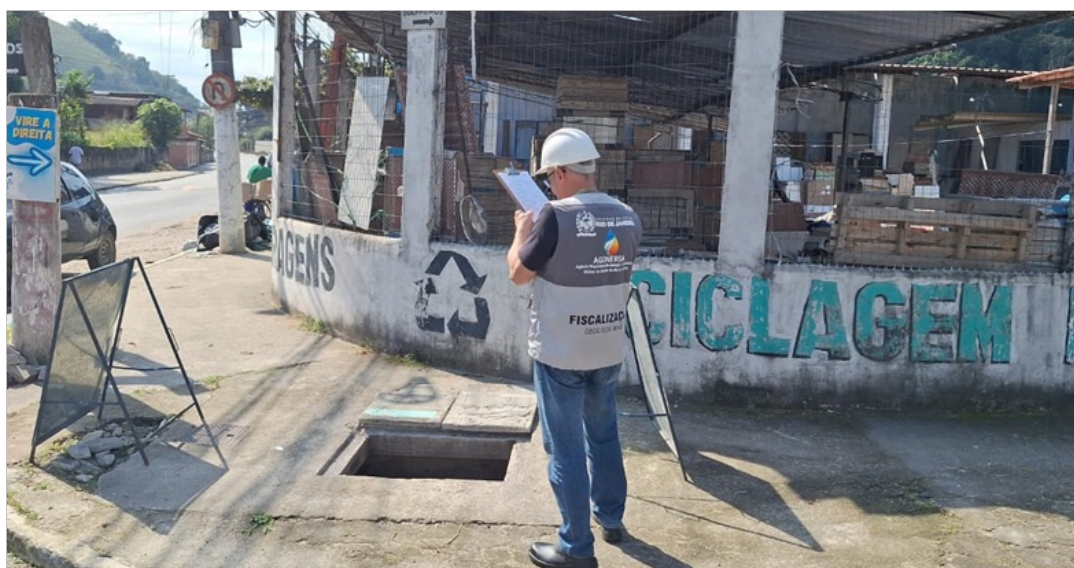
Foto 1 – Abrigo subterrâneo da motobomba
