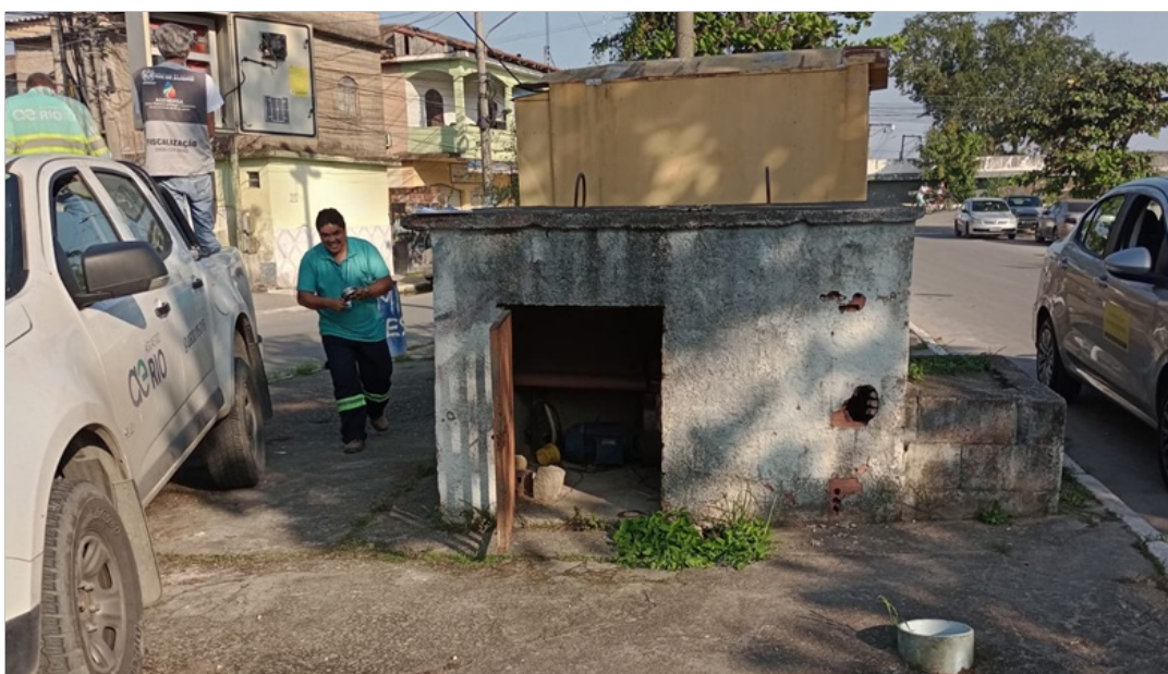
Foto 1 – Localização da EEAT 791 - Canal
