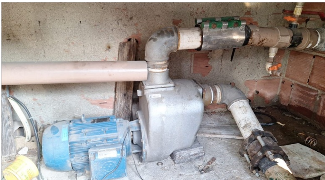
Foto 2 – Interior do abrigo
