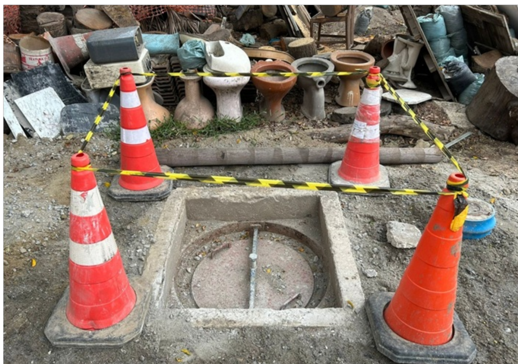
Foto 2 – Tampa de aço do abrigo da motobomba
