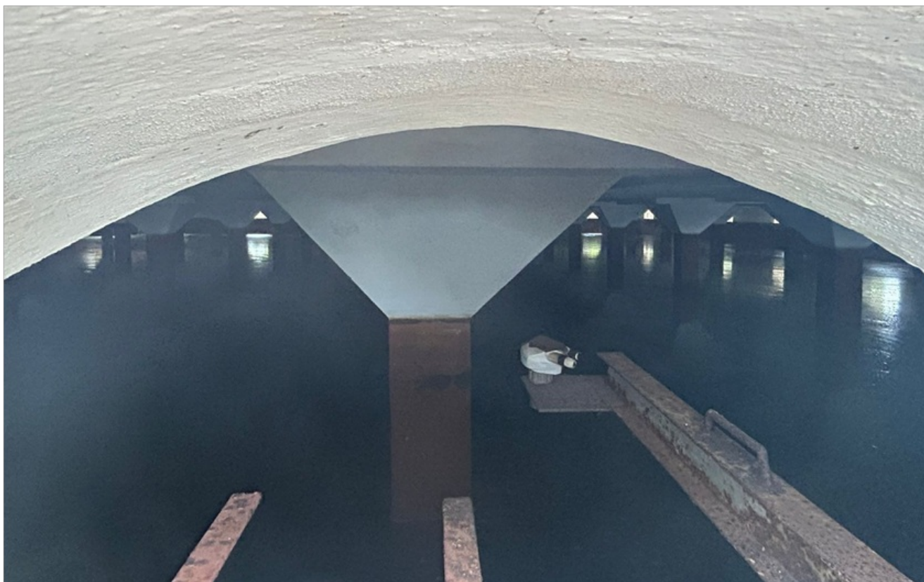
Foto 7 – Parte interna do reservatório
