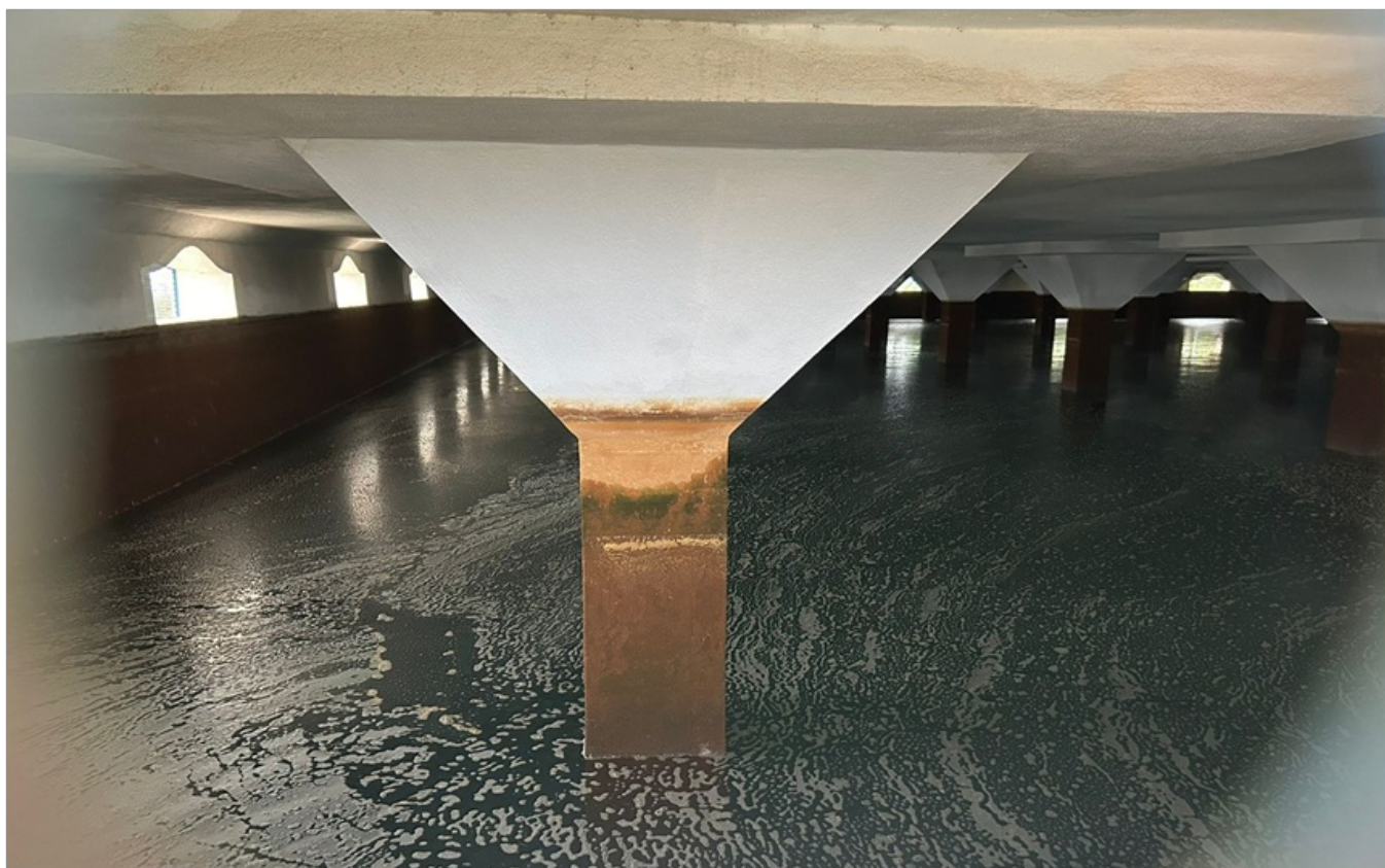
Foto 8 - Parte interna do reservatório
