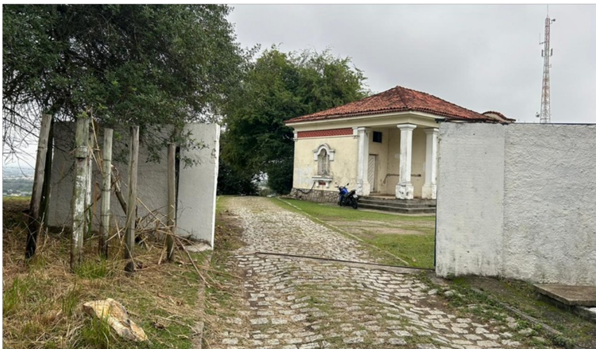
Foto 11- Entrada do reservatório sem identificação da Concessionária atual
