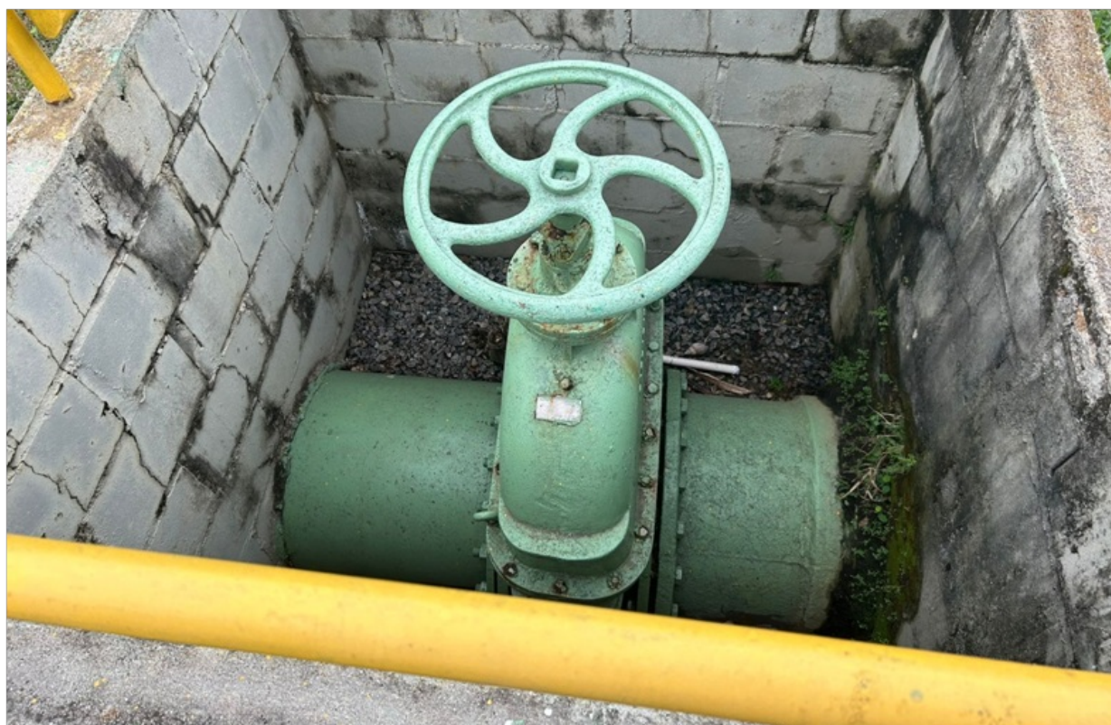
Foto 23 - Tubulação de saída do reservatório
