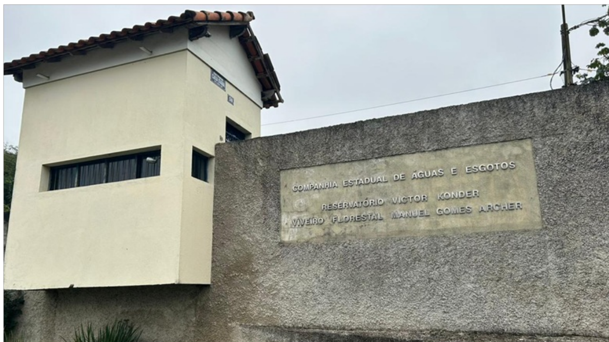
Foto 10 – Entrada do Complexo sem identificação da Concessionária atual, que é também gestora
