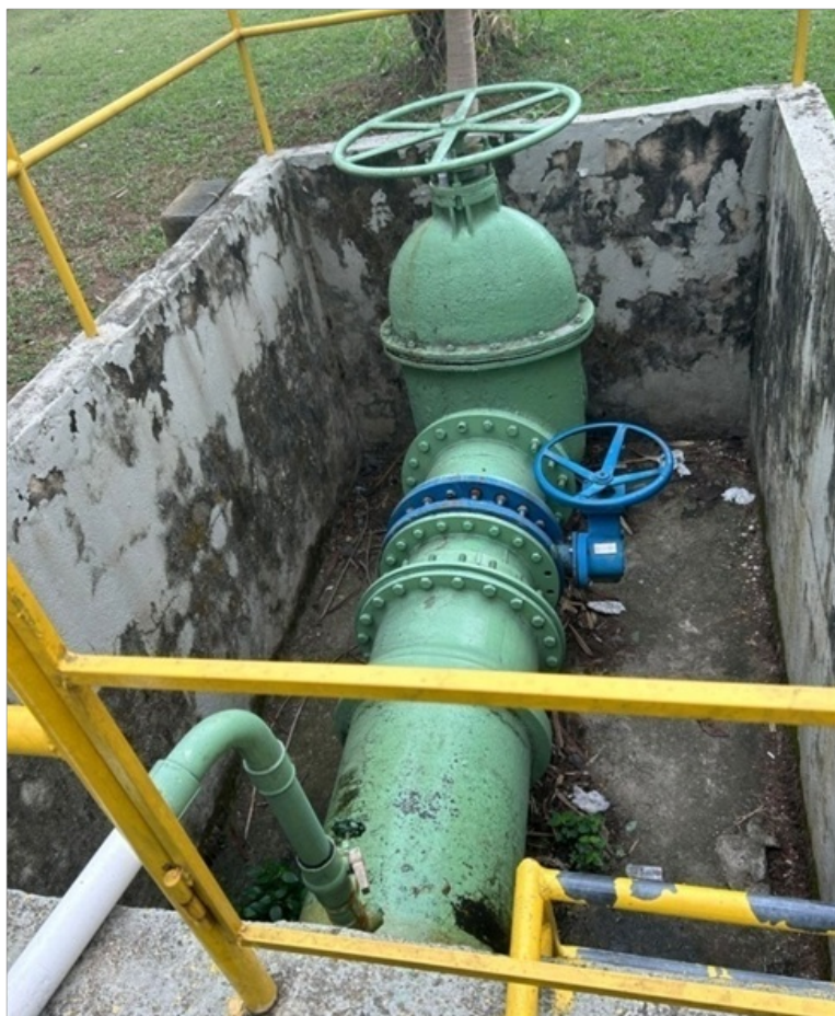
Foto 22 – Tubulação de saída do reservatório
