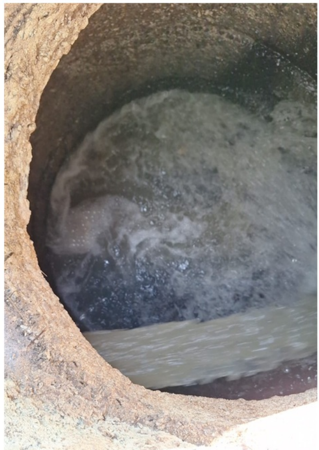
Fotos 5 e 6 – Vista do Poço de Visita onde a EEE recalca o esgoto para ser transportado por gravidade
