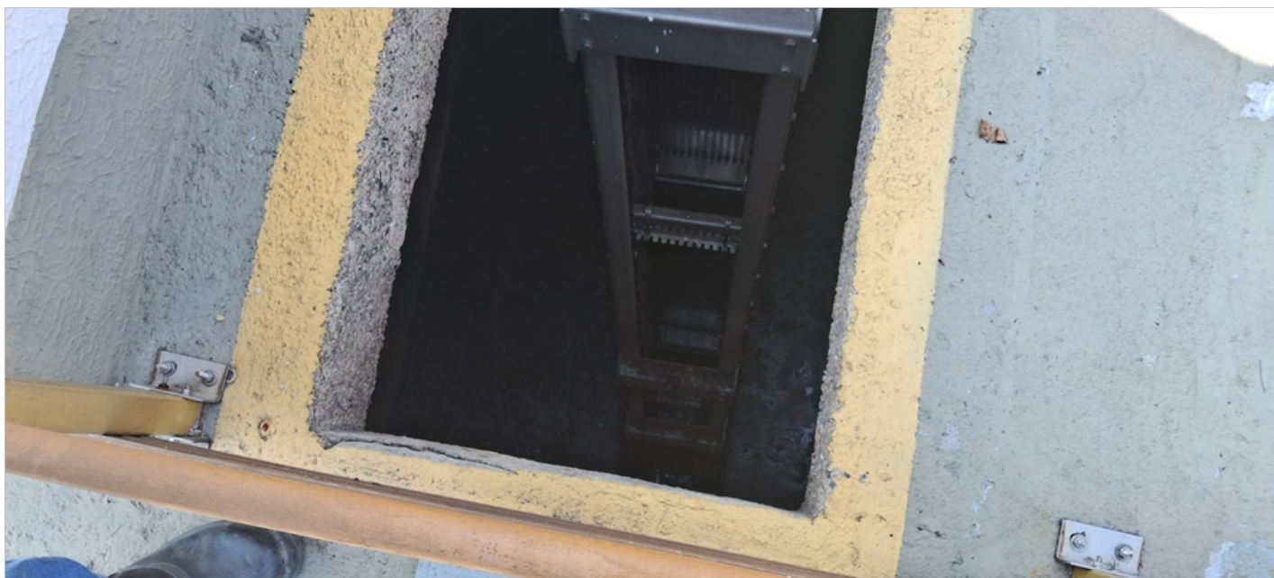
Foto 3 - Vista do interior do poço de gradeamento.
