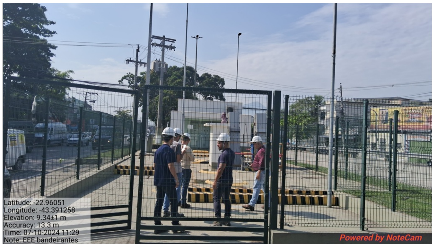
Foto 1 - Vista do portão de entrada da estação.
