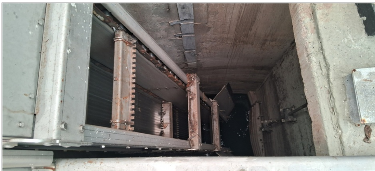
Foto 7 - Interior do poço de gradeamento.
