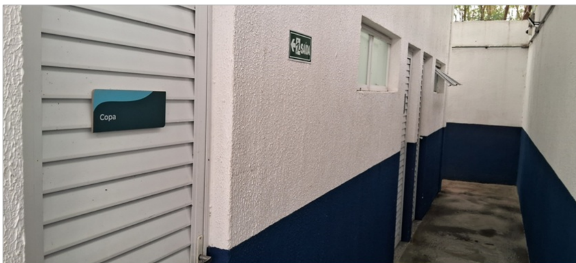
Foto 5 - Prédio de apoio administrativo.
