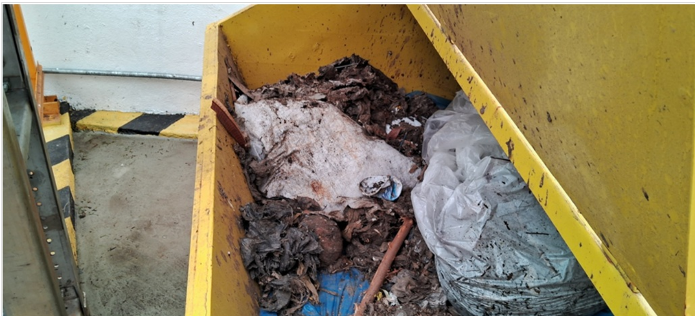
Foto 8 – Caçamba com os resíduos do gradeamento.
