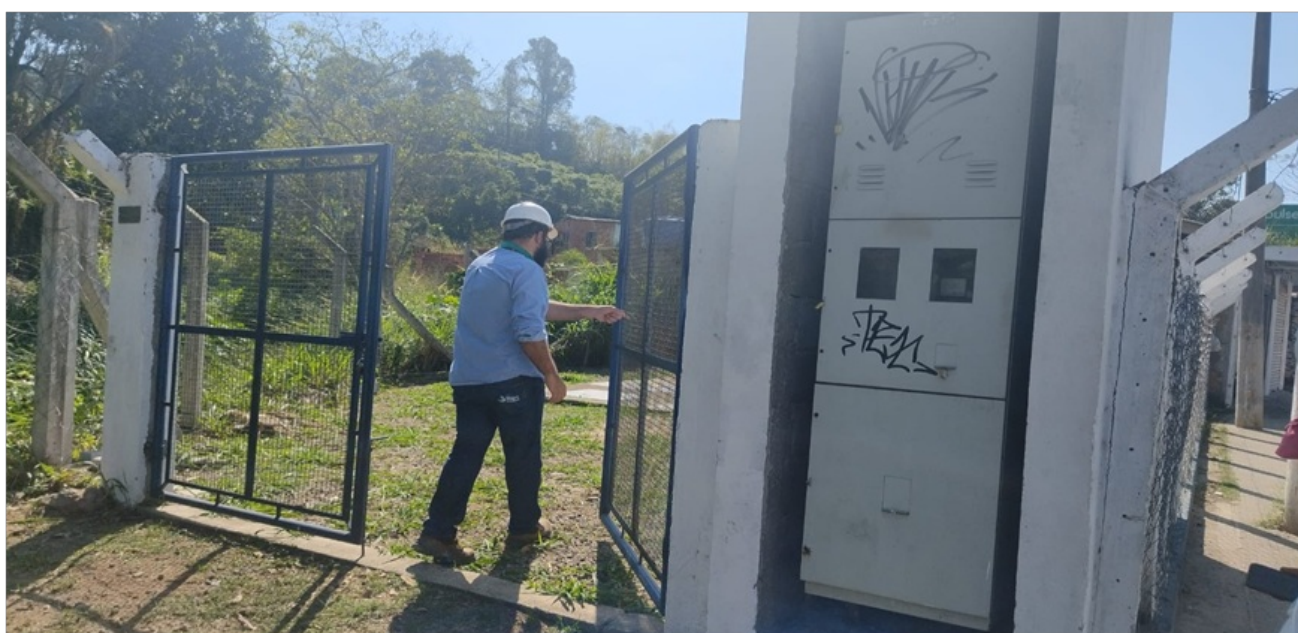
Foto 22 - Vista da parte externa da Estação Elevatória de Esgoto.
