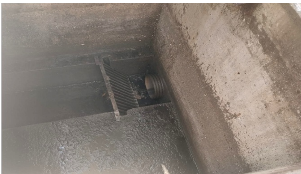
Foto 24 – Gradeamento da Estação Elevatória.
