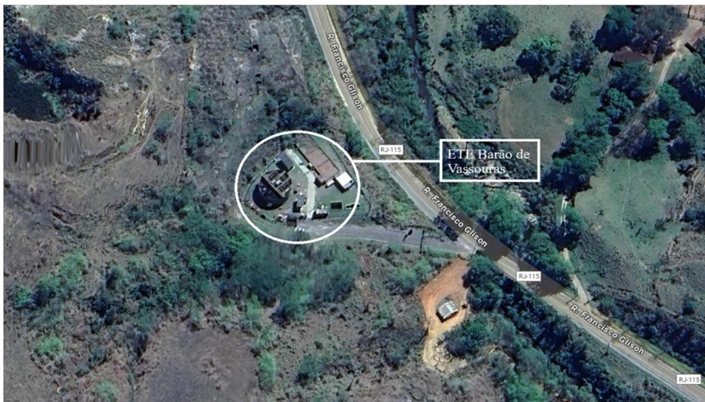
Imagem 1: localização da ETE Barão de Vassouras.
