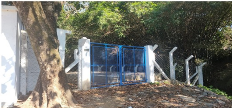
Foto 28 - Vista da parte externa da Estação Elevatória de Esgoto.
