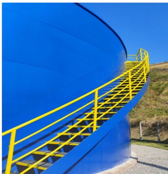
Foto 07 – Acesso ao Reator UASB + BAS.
