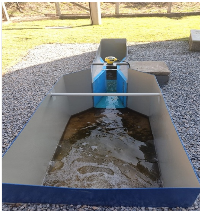
Foto 16 – Medidor de vazão do efluente clarificado.
