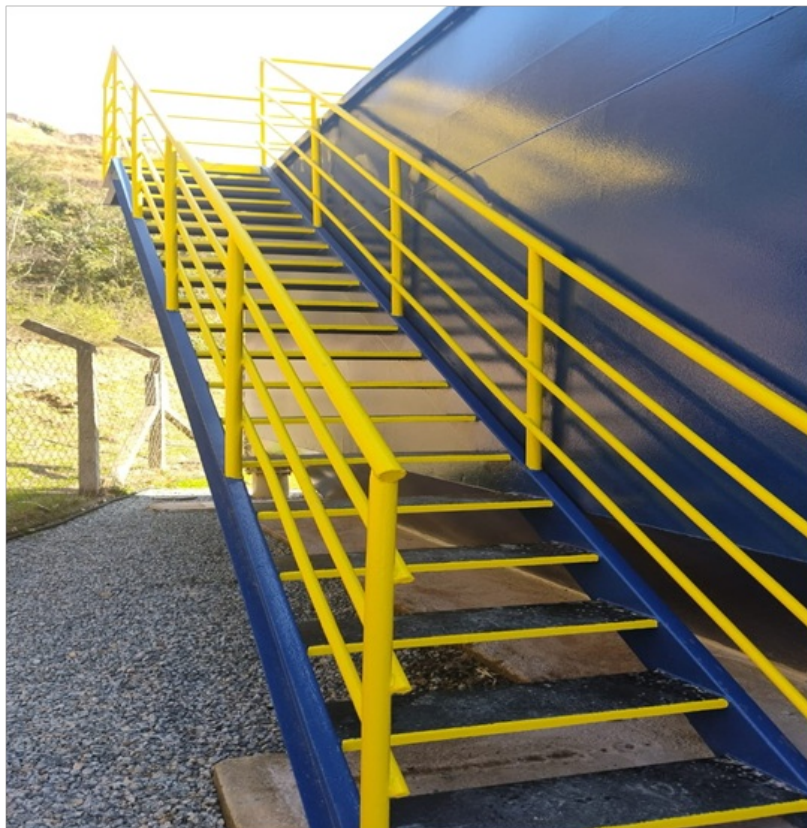
Foto 14 – Acesso ao Decantador Secundário.
