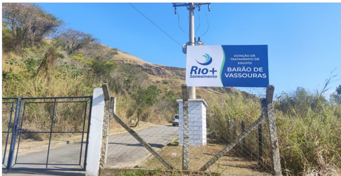
Foto 01 – Vista da entrada da ETE.
