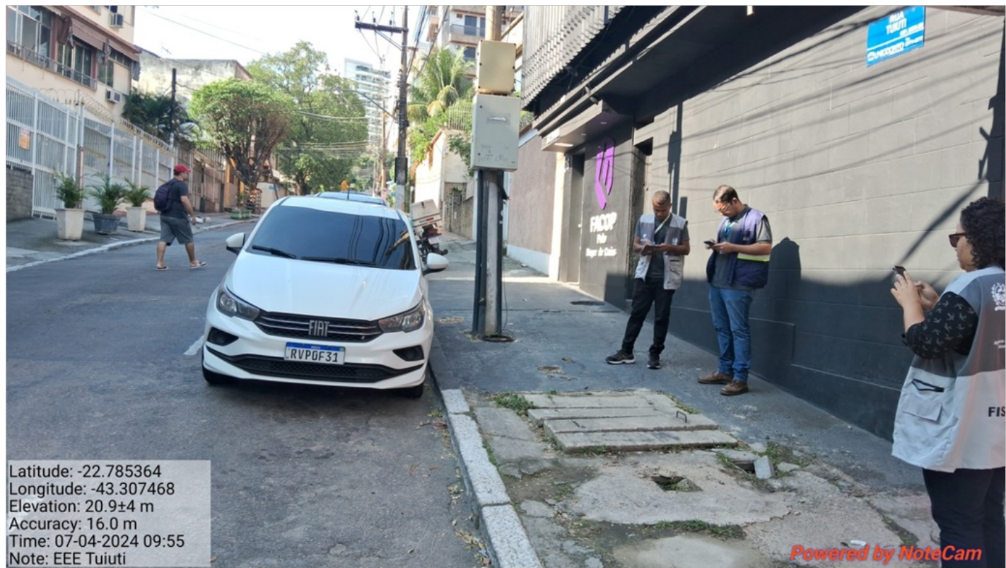
Foto 1 – Vista geral da estação. Destaca-se que não há identificação, nem sinalização viária para pedestres e nem para-raio. A tampa não está nivelada com o passeio, oferecendo perigo aos pedestres.
