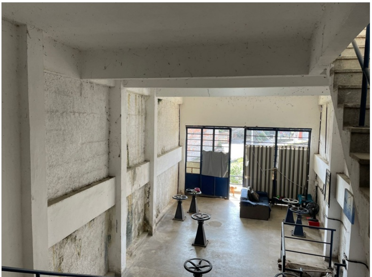
Foto 3 – Interior do reservatório, entre as duas células, onde podem ser vistas as válvulas de manobra
