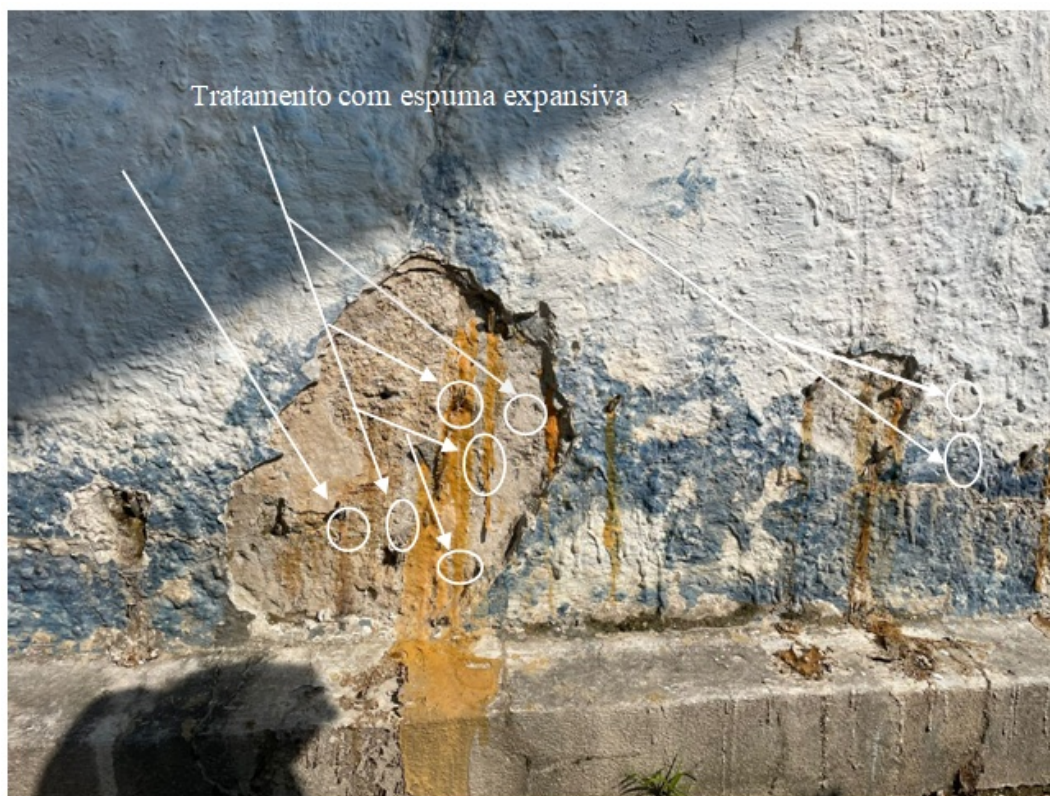
Foto 18 – Identificação dos pontos que foram inseridos a espuma expansiva
