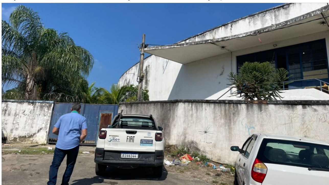
Foto 1 – Frente do reservatório
