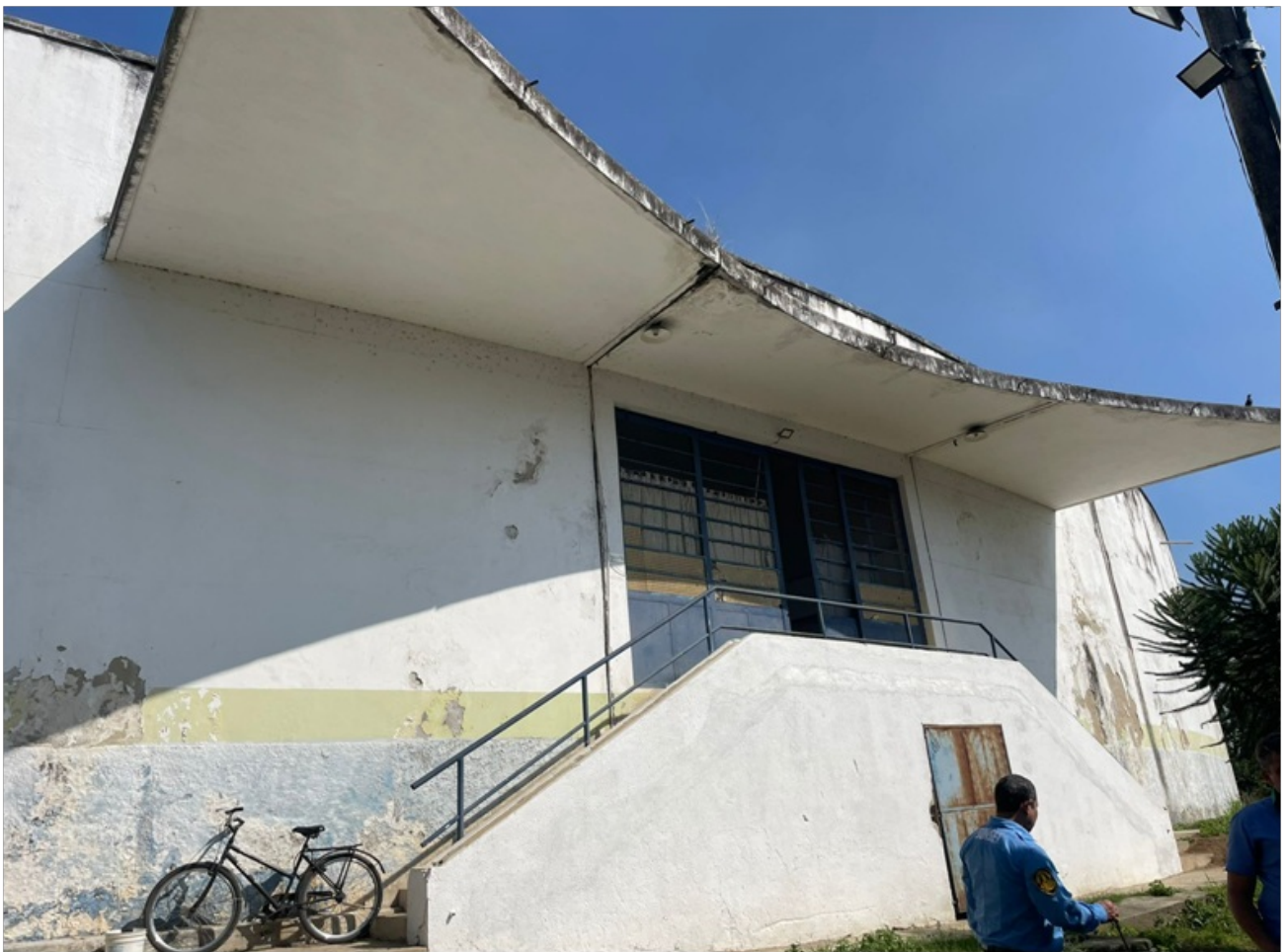
Foto 2 – Frente do reservatório
