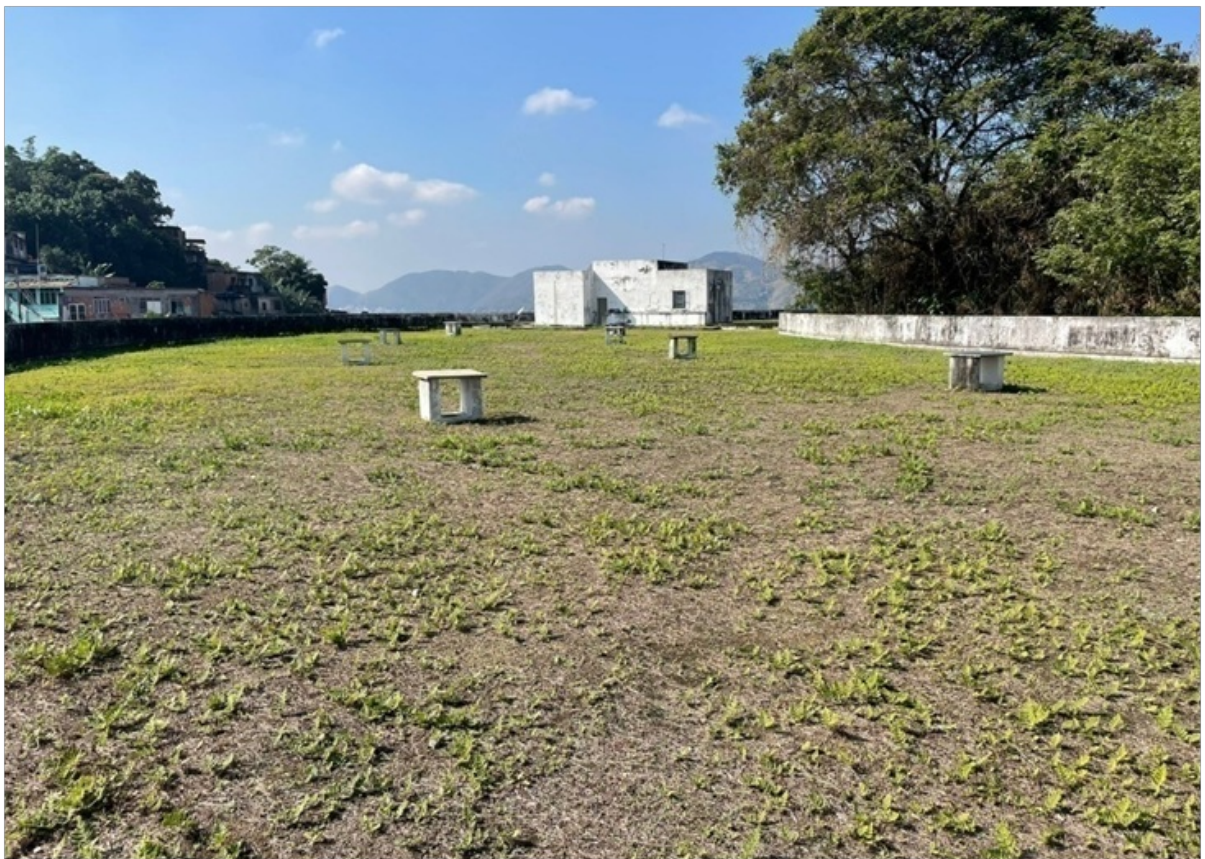
Foto 16 – Dutos sem proteção lateral
