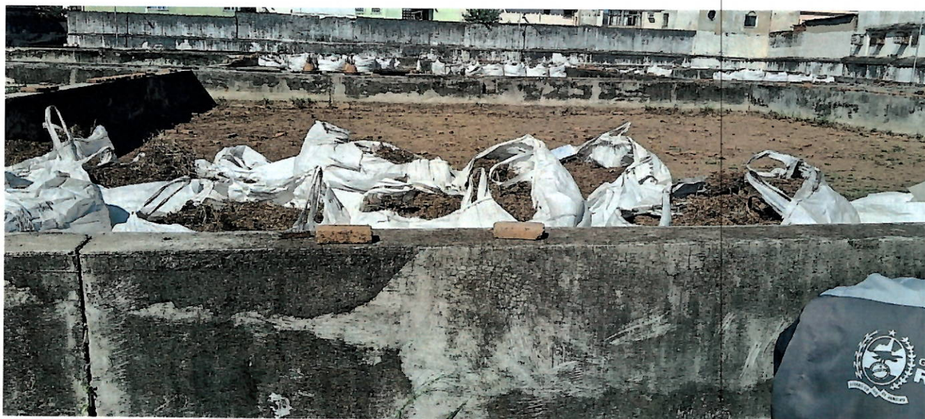
Foto 36 - Lodo seco ensacado para descarte.
