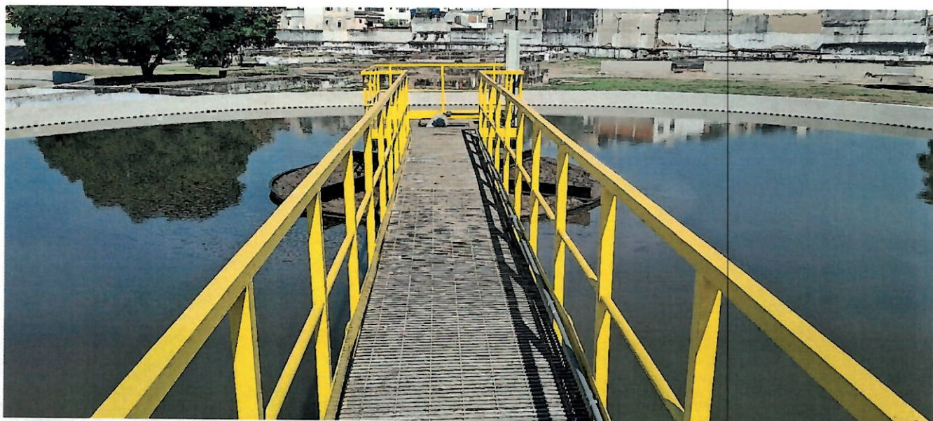
Foto 23 - Passarela reformada sobre o decantador secundário.
