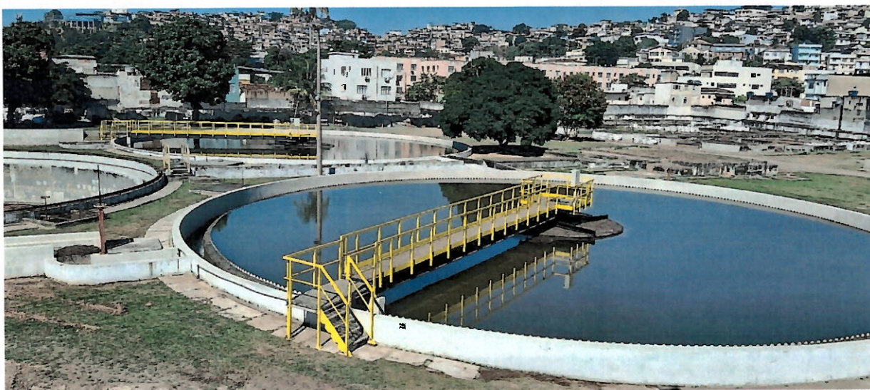
Foto 21 - Vista superior dos decantadores secundários.
