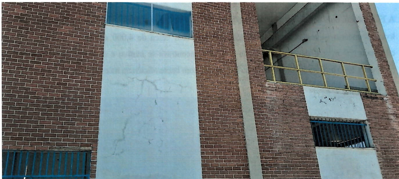
Foto 30 - Fachada do prédio do adensamento do lodo.
