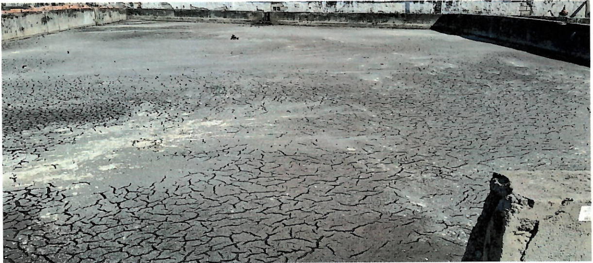
Foto 34 - Vista de uma das câmaras do leito de secagem preenchida com lodo em estado avançado de secagem.
