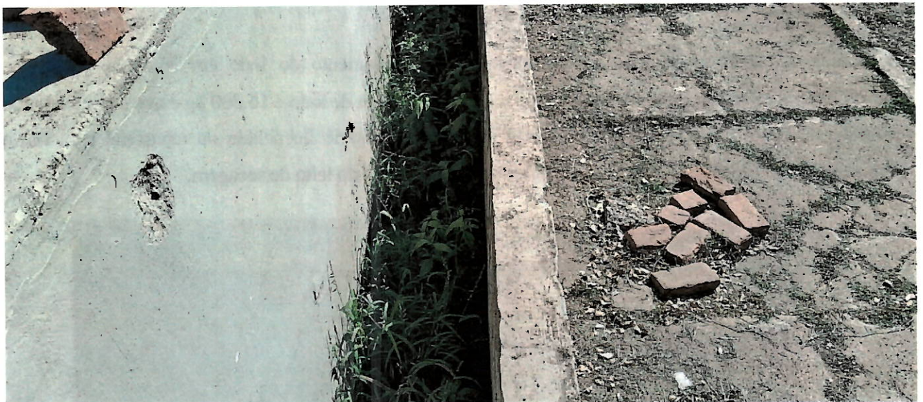
Foto 35 - Canaleta de drenagem do leito de secagem com presença de vegetação.
