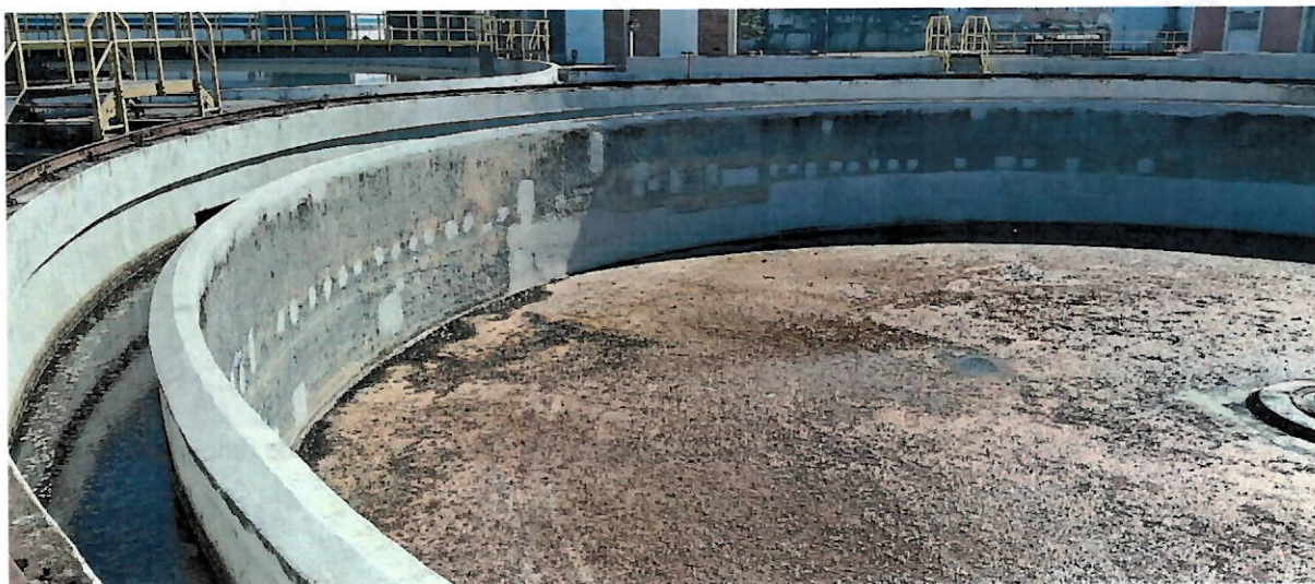
Foto 22 - Decantador em obra de manutenção.
