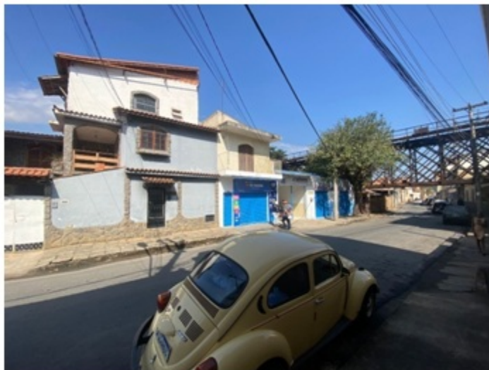
Foto 02 – Residências no Logradouro, afetadas pelo despejo do esgoto in natura.
