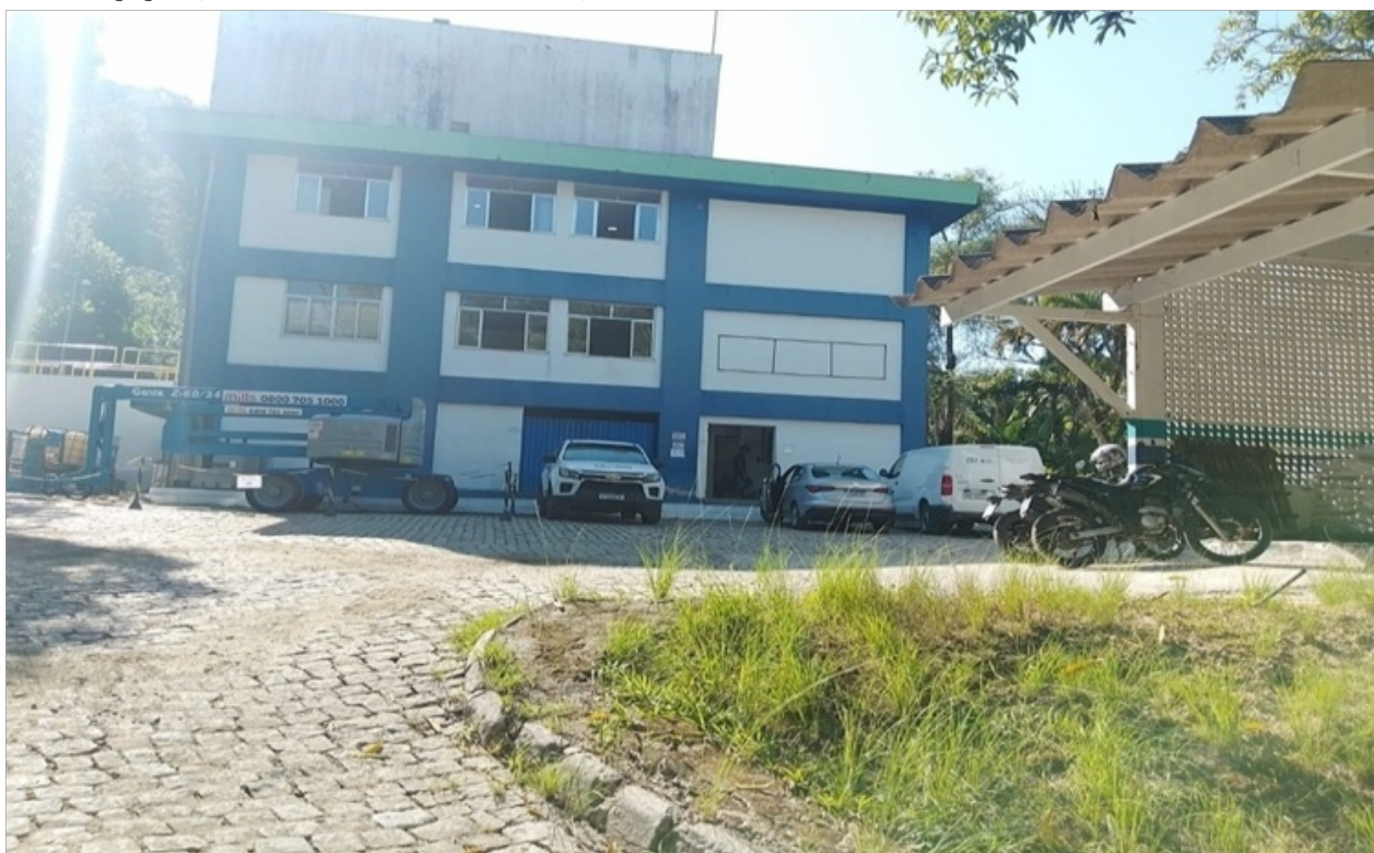
Foto 01 – Vista da fachada da Unidade de Tratamento Rio Bonito.
