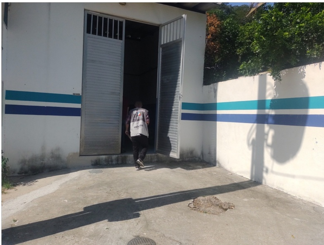
Foto 1 – Fachada do abrigo
