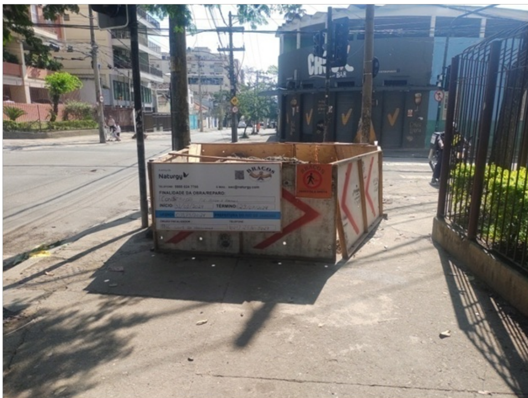
Foto 2 – Tapume Rua Aquidabã esquina Rua Vilela Tavares
