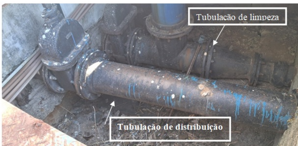
Foto 5 – Tubulações de distribuição e de limpeza
