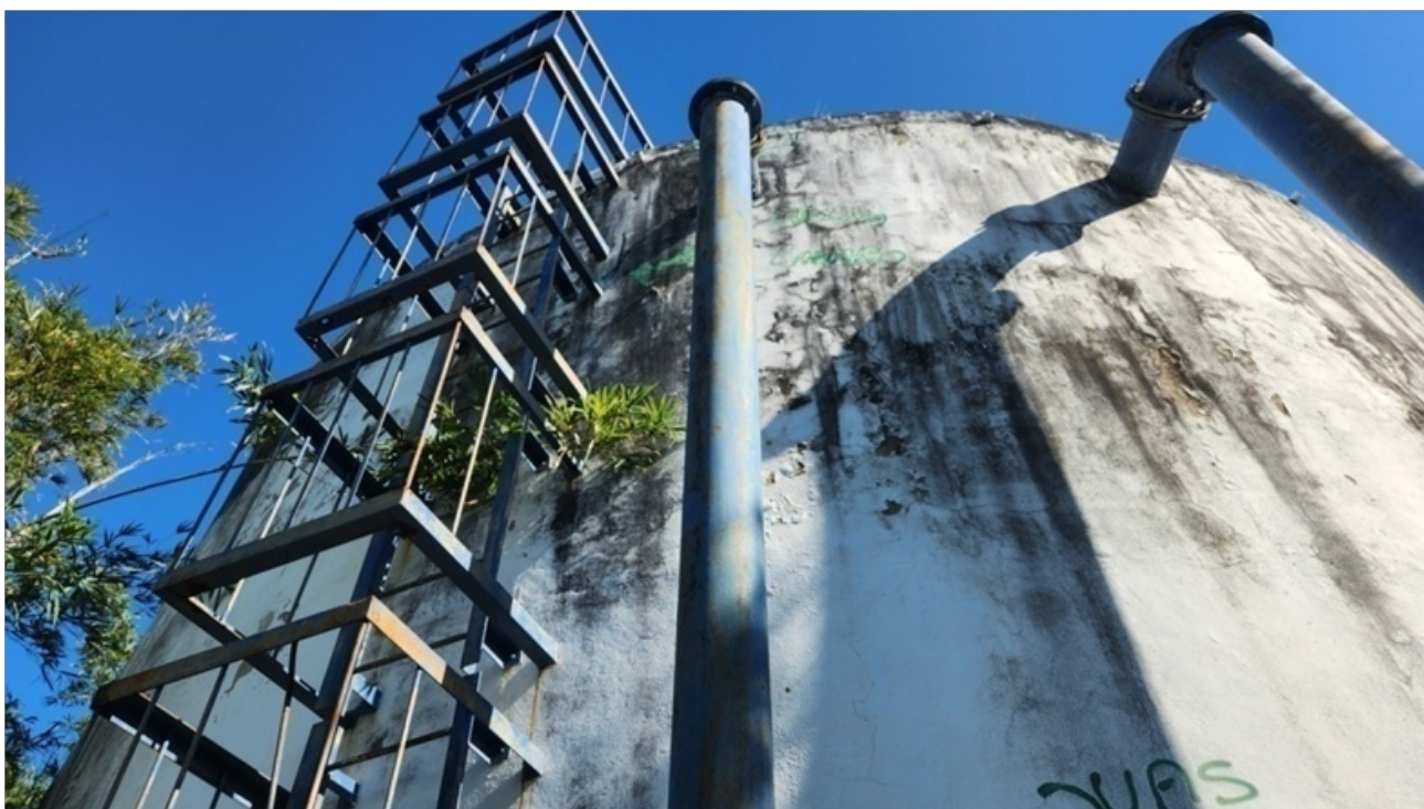
Foto 3 – Escada fixa, com proteção
