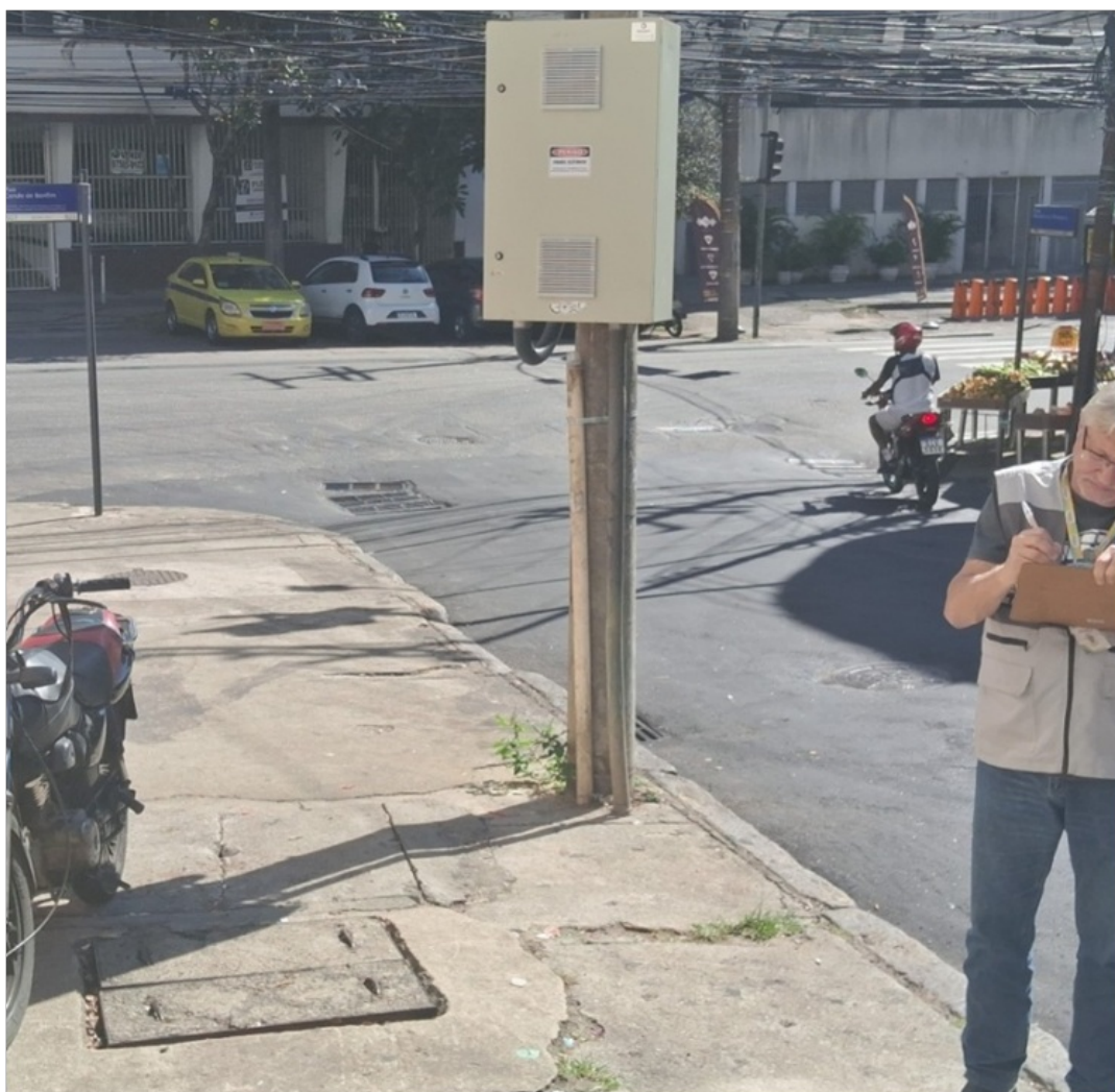
Foto 1 – Vista do abrigo da bomba e do painel elétrico
