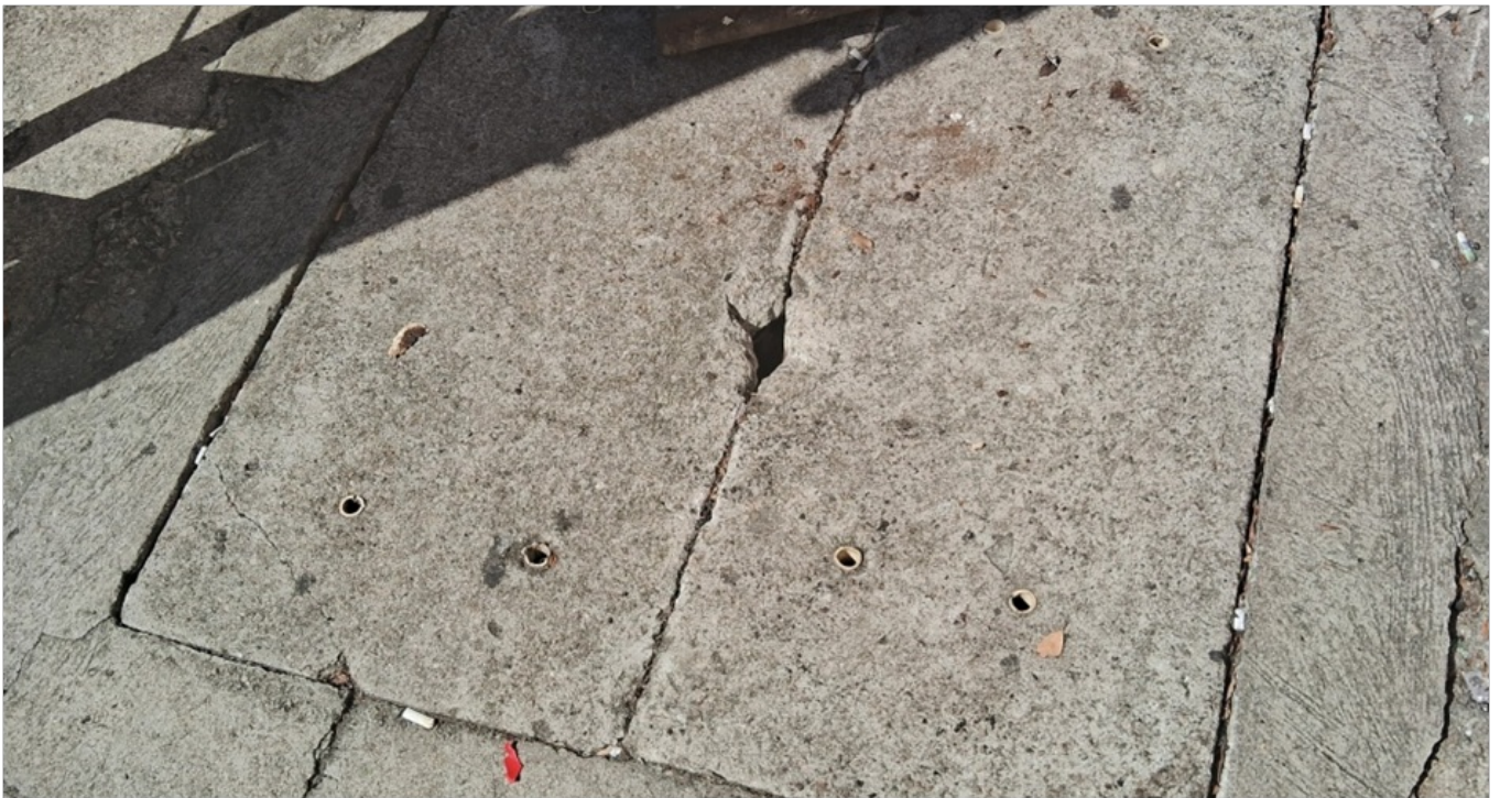
Foto 6 – Tampa de concreto da EEAT
