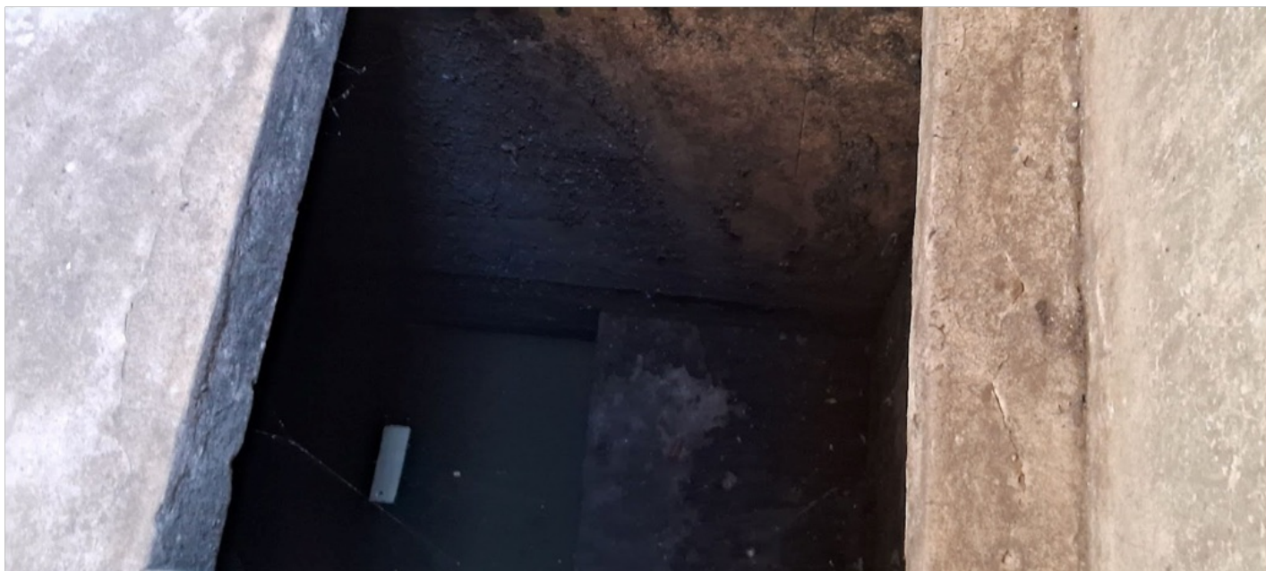
Foto 9 - Vista do interior do poço de sucção.
