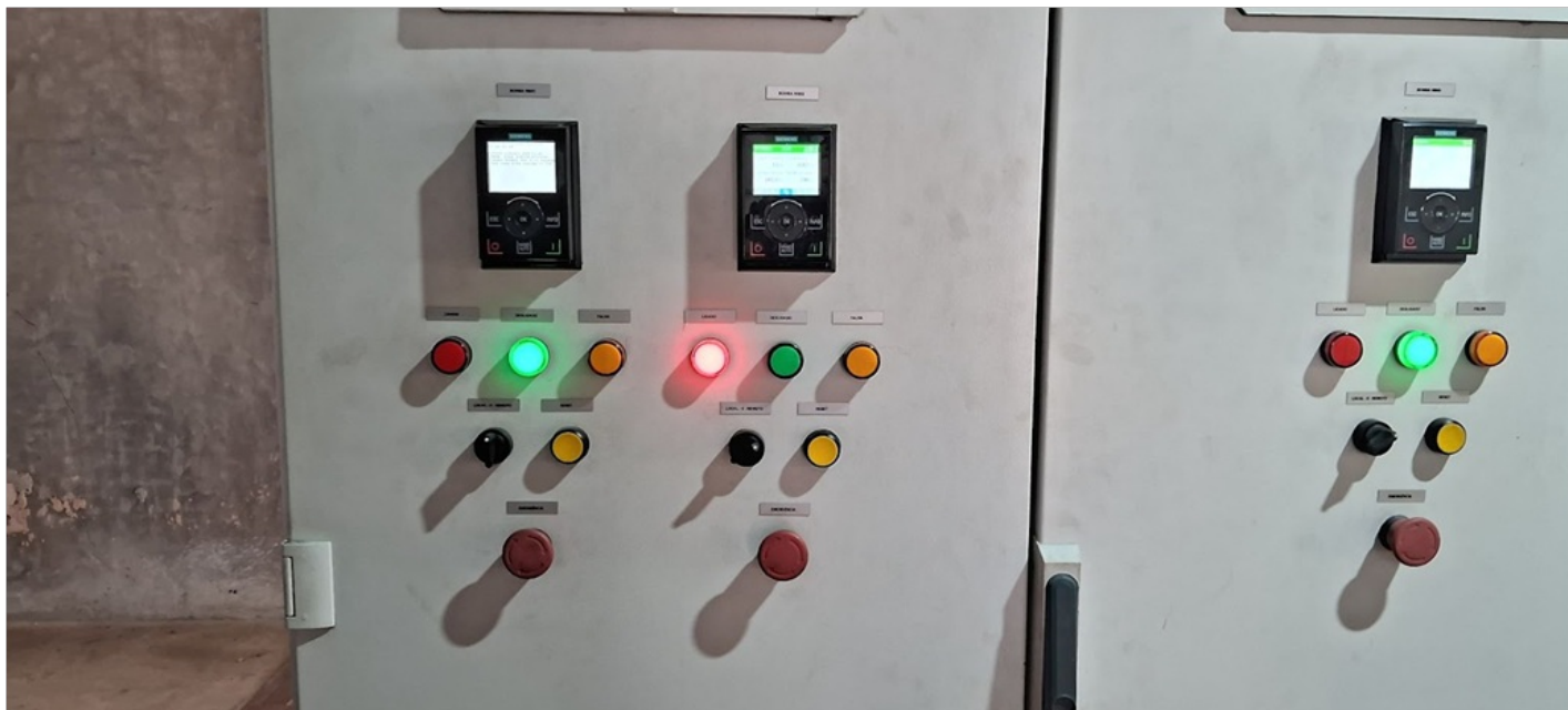
Foto 12 - Painel elétrico de acionamento das bombas.
