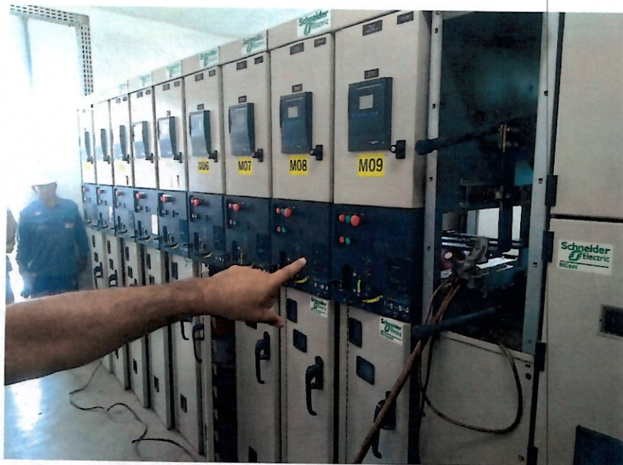
Foto 10 – Manutenção sendo realizada nos painéis elétricos.
