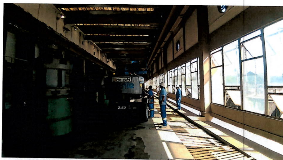
Foto 6 – manutenção sendo realizada nos grupos motor bombas do BRG.
