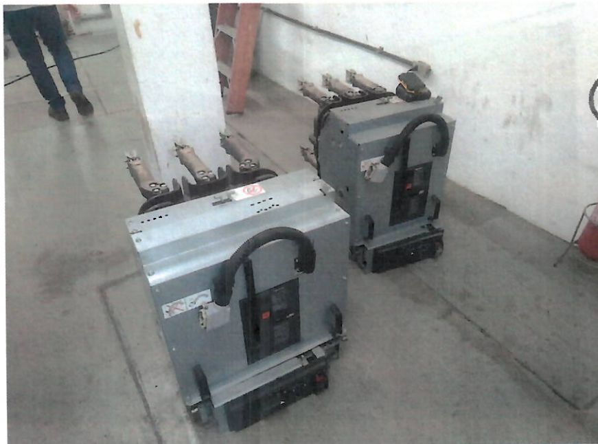
Foto 11 – Manutenção sendo realizada nos disjuntores.
