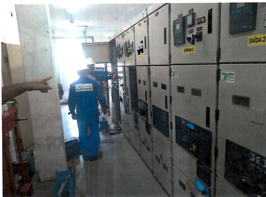
Foto 8 – Manutenção sendo realizada nos painéis elétricos.
