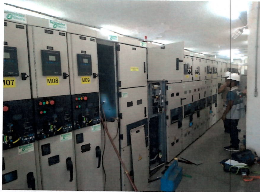
Foto 9 – Manutenção sendo realizada nos painéis elétricos.
