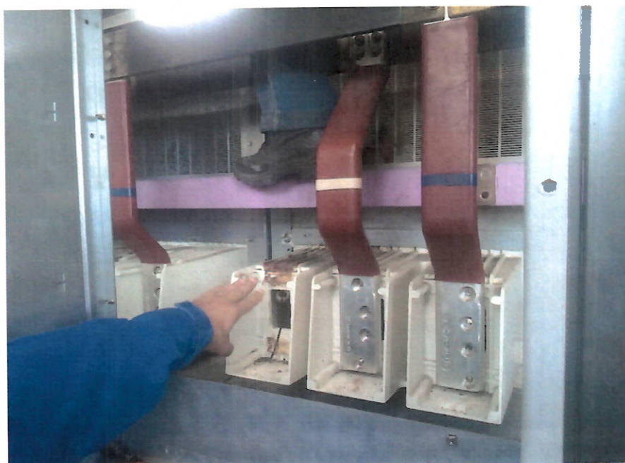
Foto 12 – Manutenção sendo realizada no barramento elétrico.
