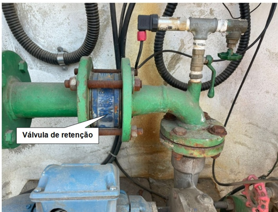
Foto 5 – Válvula de retenção DN 65mm
