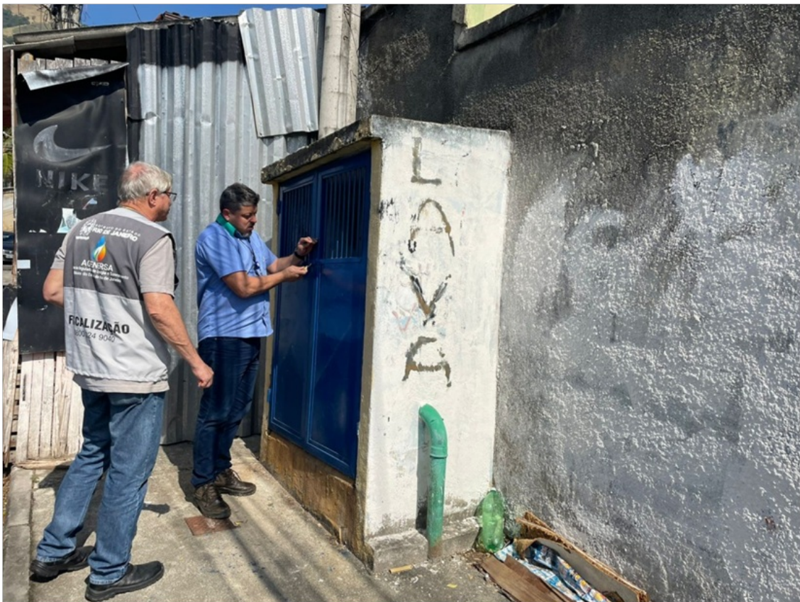
Foto 1 - Localização da EEAT Caminho do Borges na calçada de via pública
