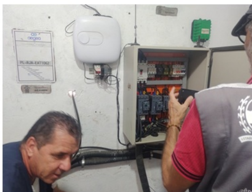
Foto 5 e 6 - Quadro de comando , Inversor de frequência
