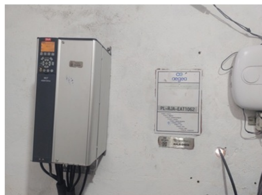
Foto 5 e 6 - Quadro de comando , Inversor de frequência
