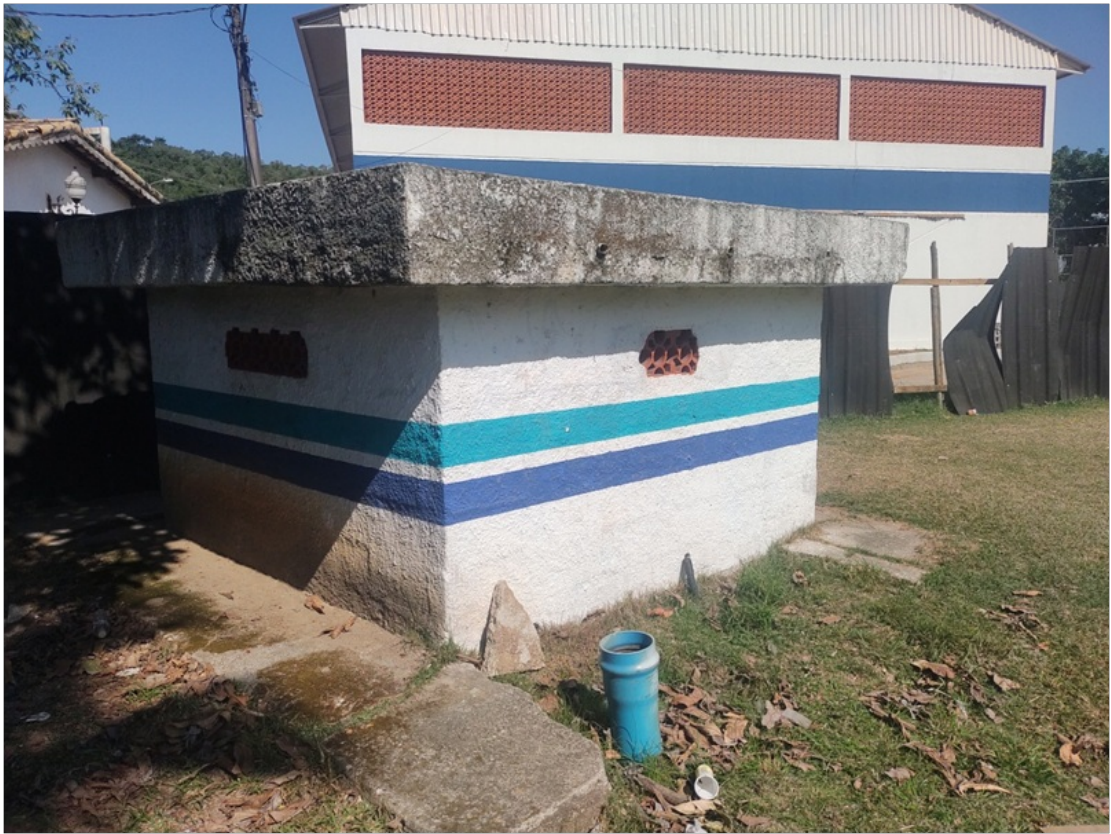
Foto 1 - Vista externa da estação.
