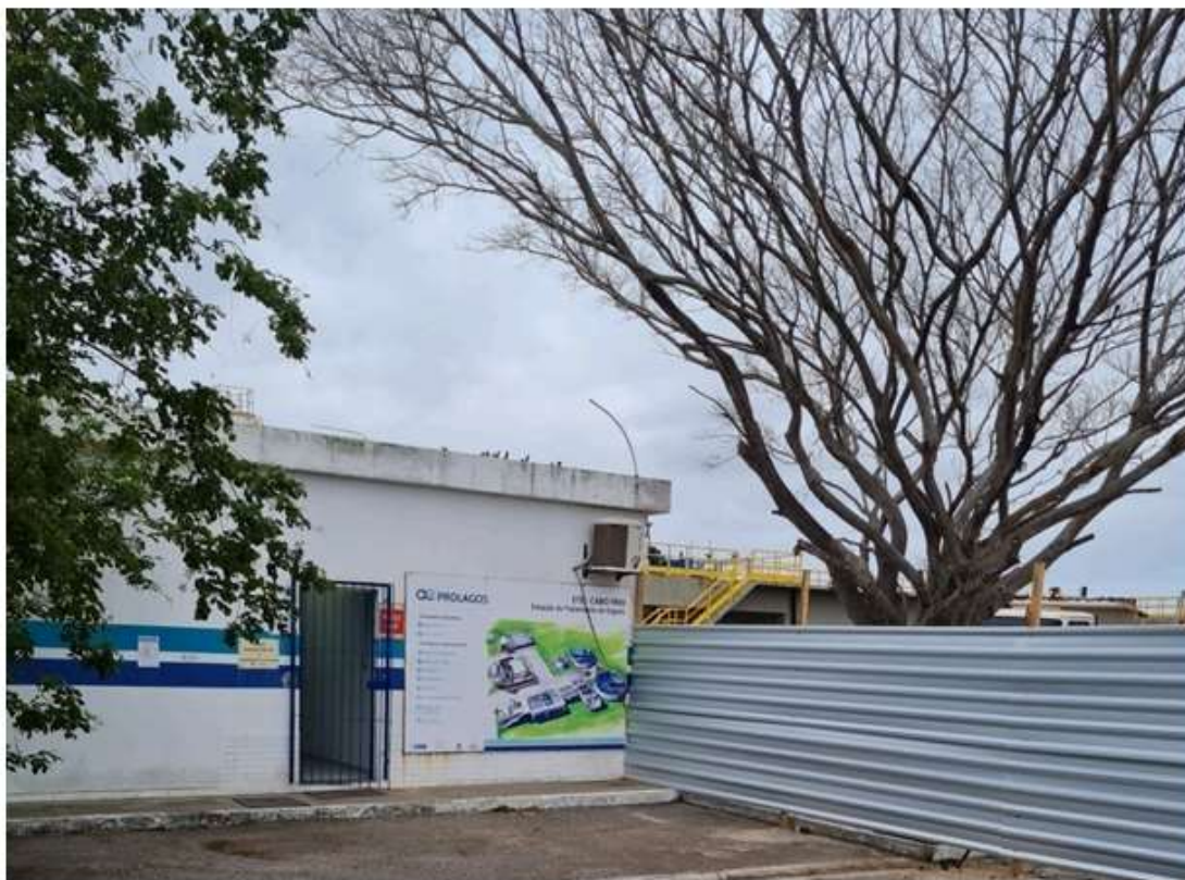
Foto 1: ETE Praia do Siqueira.
