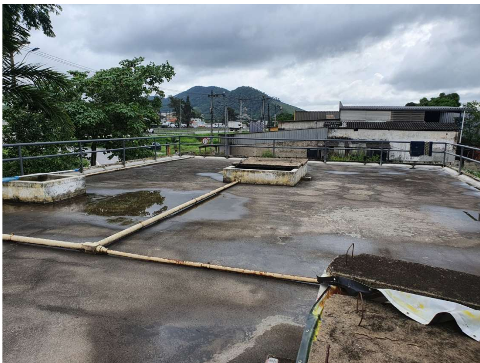
Tanque de aerção
