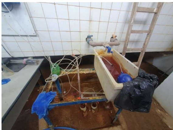
Dosador não se encontra de acordo com as normas da boa engenharia
