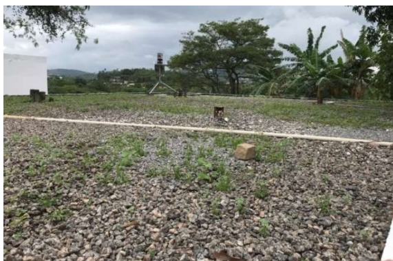
Chaminés de ventilação dos reservatórios não possuem telas de proteção
