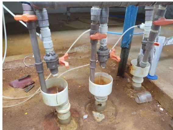
Dosador não se encontra de acordo com as normas da boa engenharia
