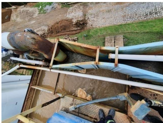
Ponto de aplicação do coagulante
