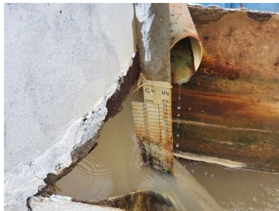
Ponto de aplicação do coagulante
