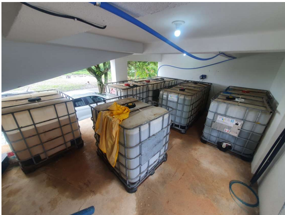
Armazenamento de Produtos Químicos
