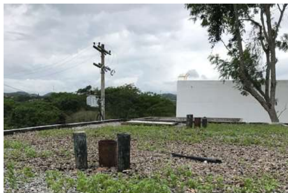
Chaminés de ventilação dos reservatórios não possuem telas de proteção
