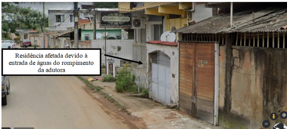
Imagem do Google Earth capturada em 21/11/2022 – Rua das Tulipas
