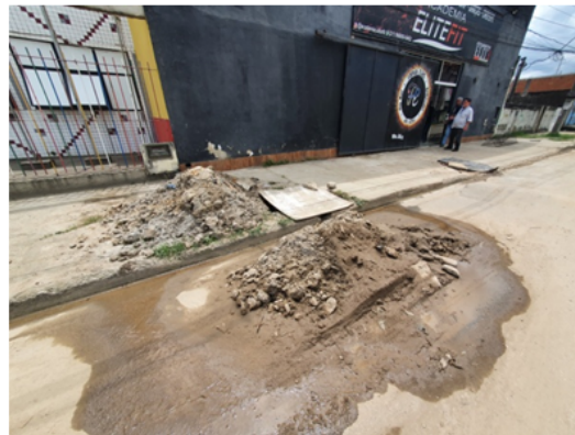
Foto nº 4 - Verificou-se o procedimento de limpeza, executado pela CEDAE, dos imóveis atingidos.
