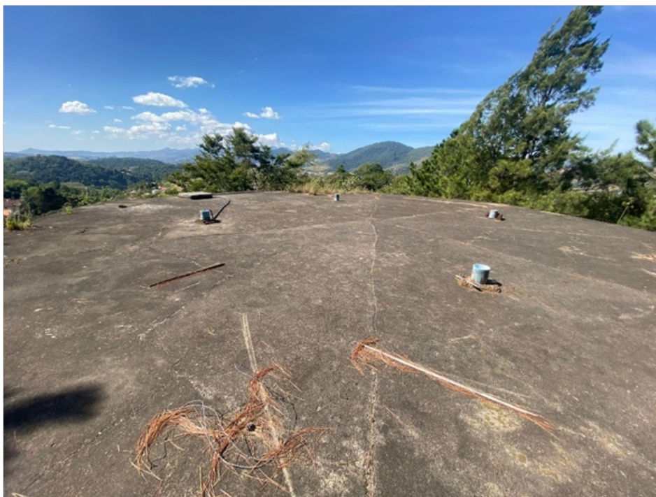
Foto7 – Parte superior do reservatório
