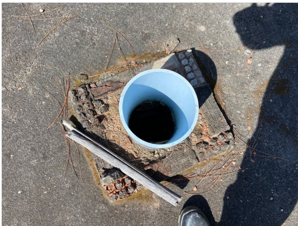
Foto 8 – Duto de ventilação
