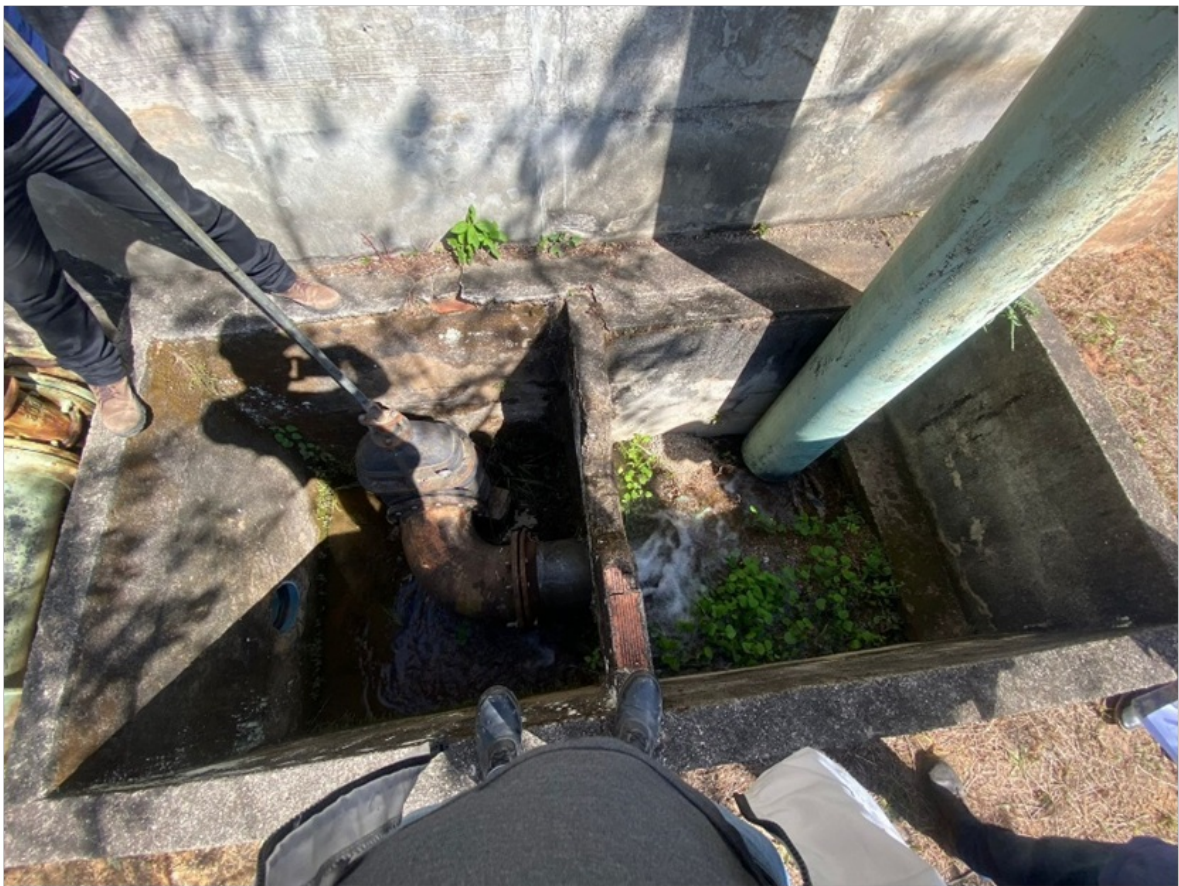
Foto5 – Tubulações de descarga de fundo e extravasor
