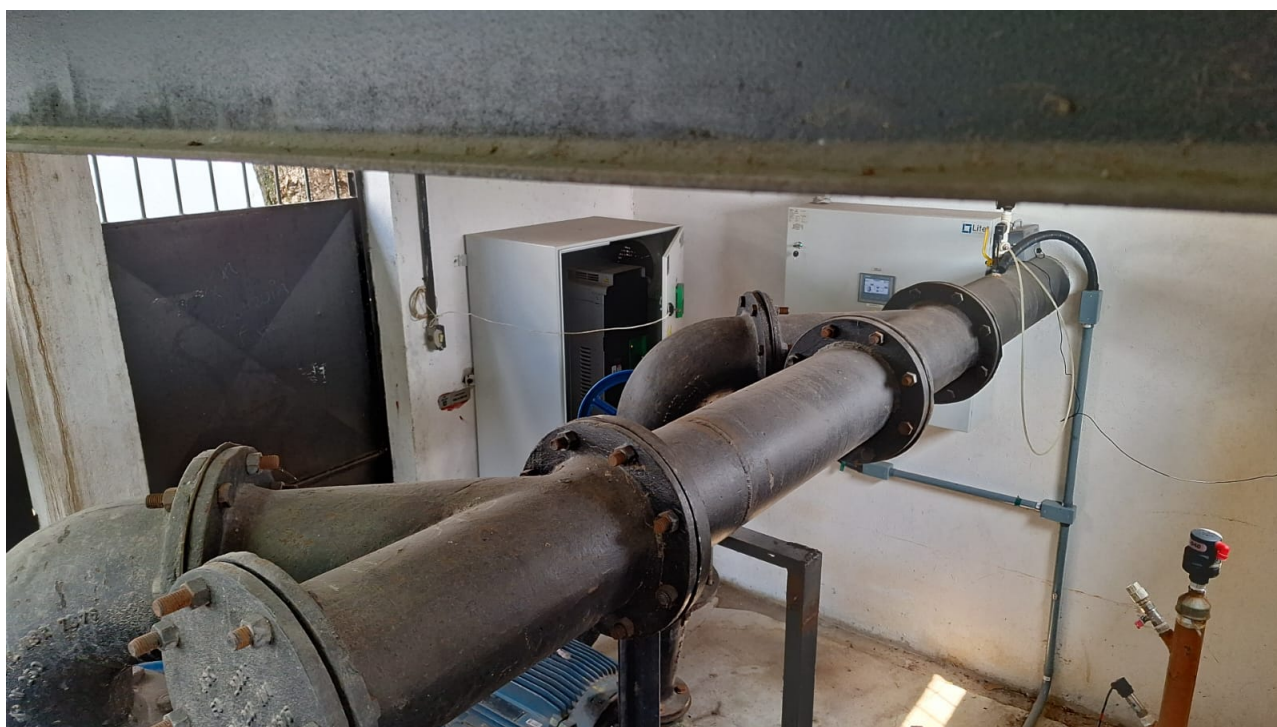
Foto 3 ( Quadro de Comando / Telemetria / Recalque das bombas
