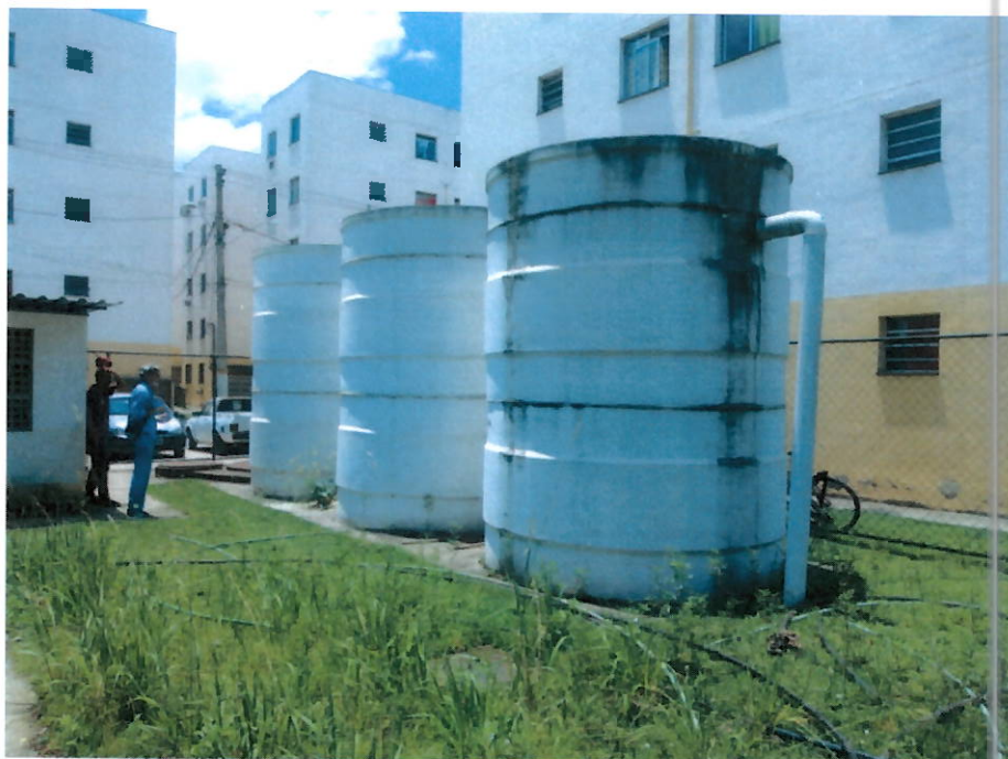
Foto 1 – Tanques anaeróbios
