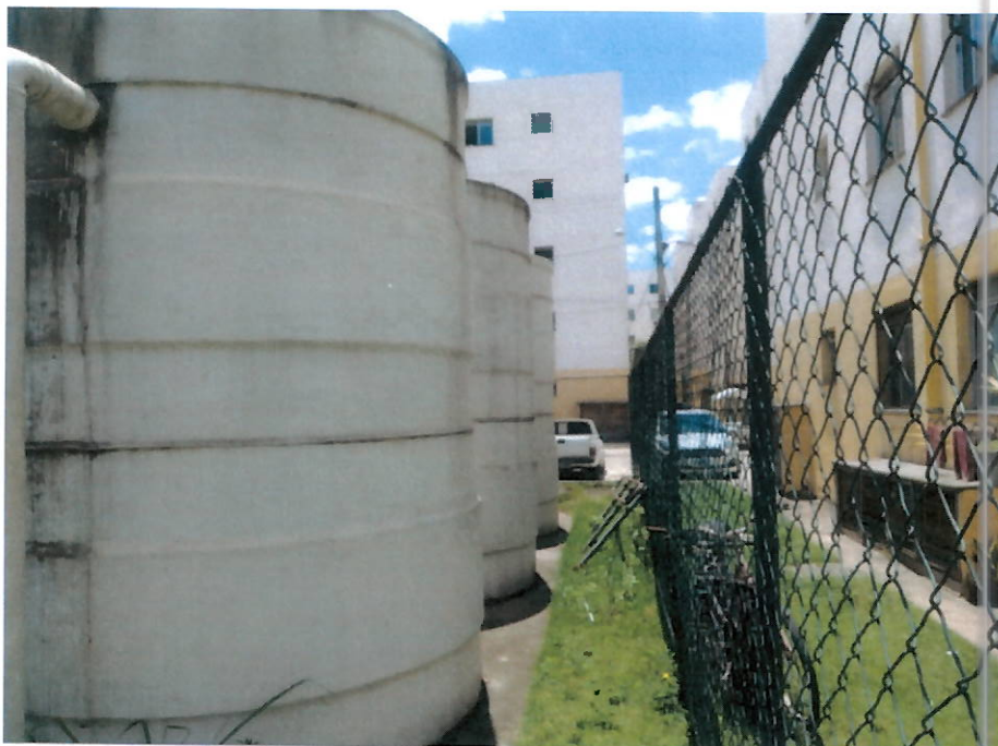
Foto 2 – Tanques anaeróbios
