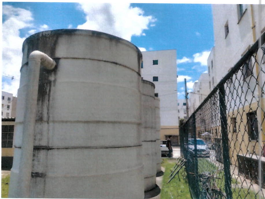
Foto 3 – Tanques anaeróbios
