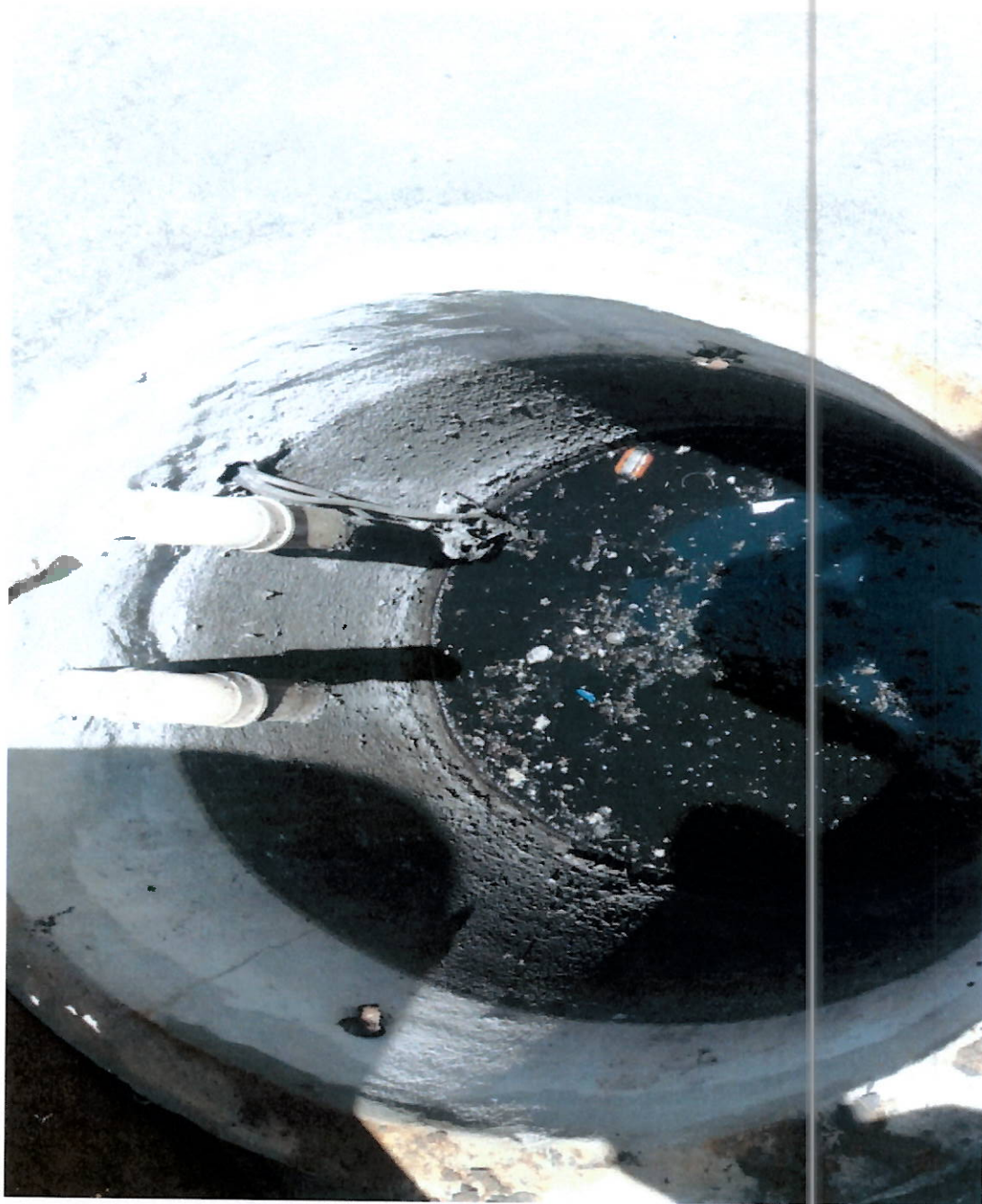
Foto 9 – Estação elevatória de esgoto internamente sem a bomba
