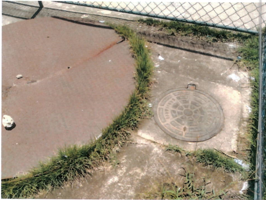
Foto 9 – Caixa retentora de resíduos sólidos e poço de visita
