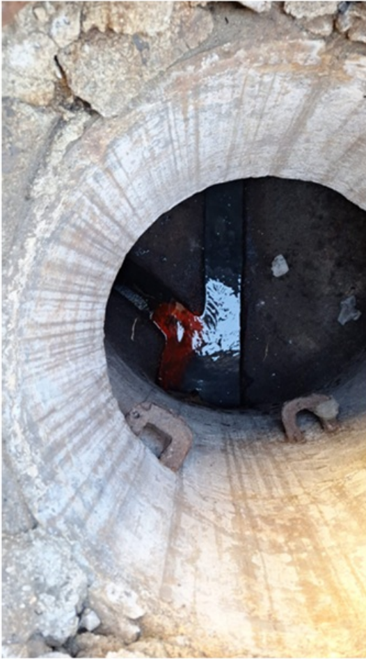
Foto 3 – PV final de descarga do esgoto com corante lançado
